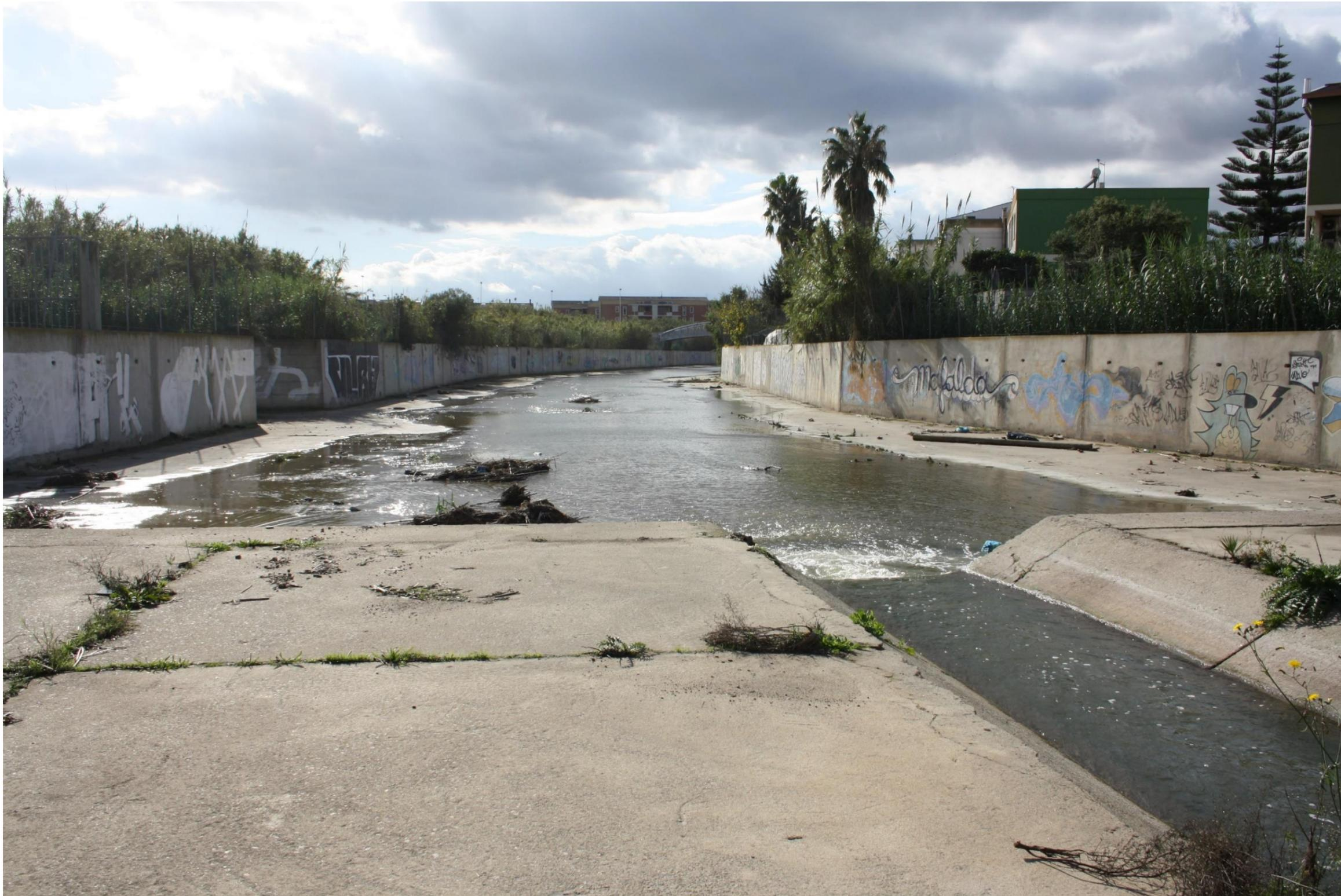
**Punto 4: Vista dall'alveo del Rio Sesto direzione mare. La figura mostra l'alveo del corso d'acqua completamente cementato; privo di vegetazione naturale. fonte: Sopralluogo Sering)**
