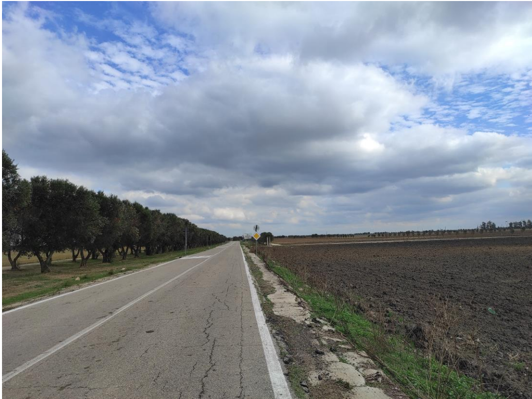
Figura P15 - Strada Provinciale 107 percorsa dal cavidotto interno di collegamento
