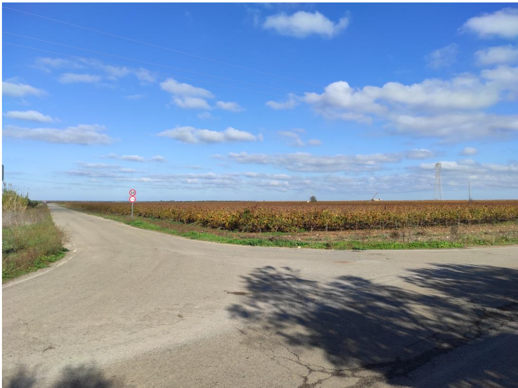
Figura P29 - Vista della dalla Strada Provinciale 144 percorsa dal cavidotto verso la Sottostazione Elettrica
