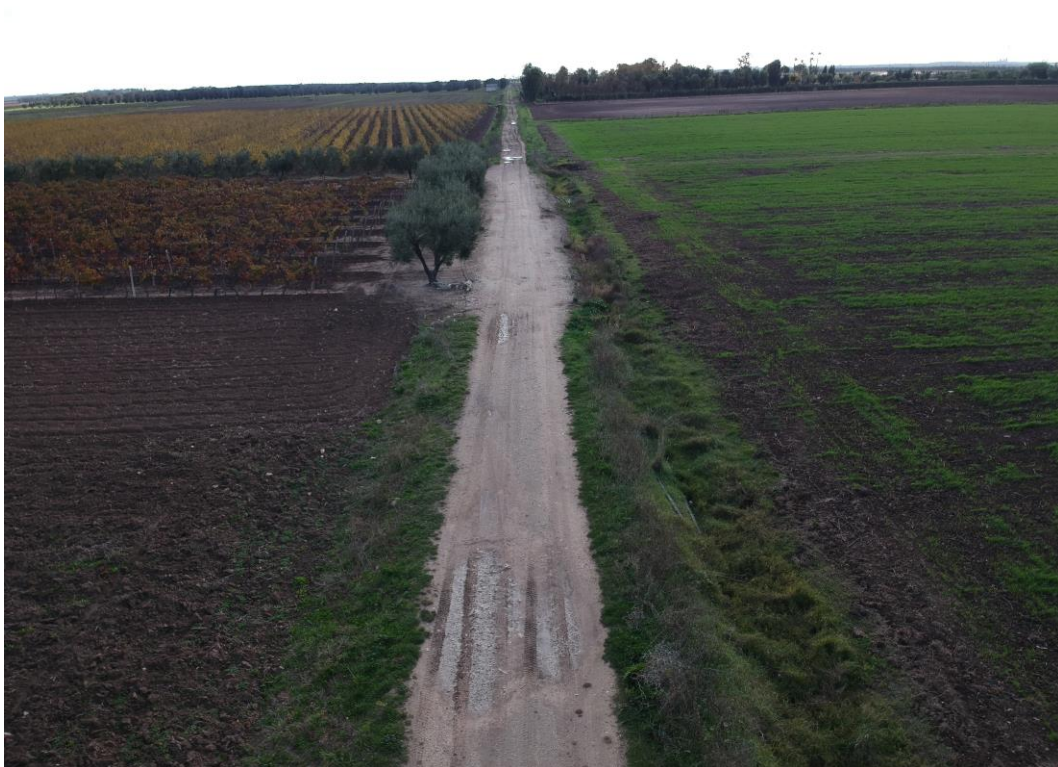
Figura P16 - Percorso del cavidotto dell'aerogeneratore SV07 (vista da nord verso sud)
