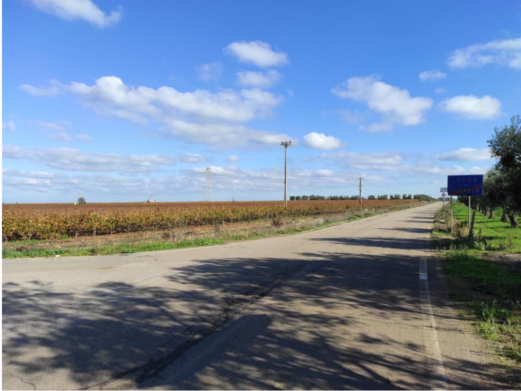
Figura P28 - Vista della dalla Strada Provinciale 107 percorsa dal cavidotto in direzione della Sottostazione Elettrica
