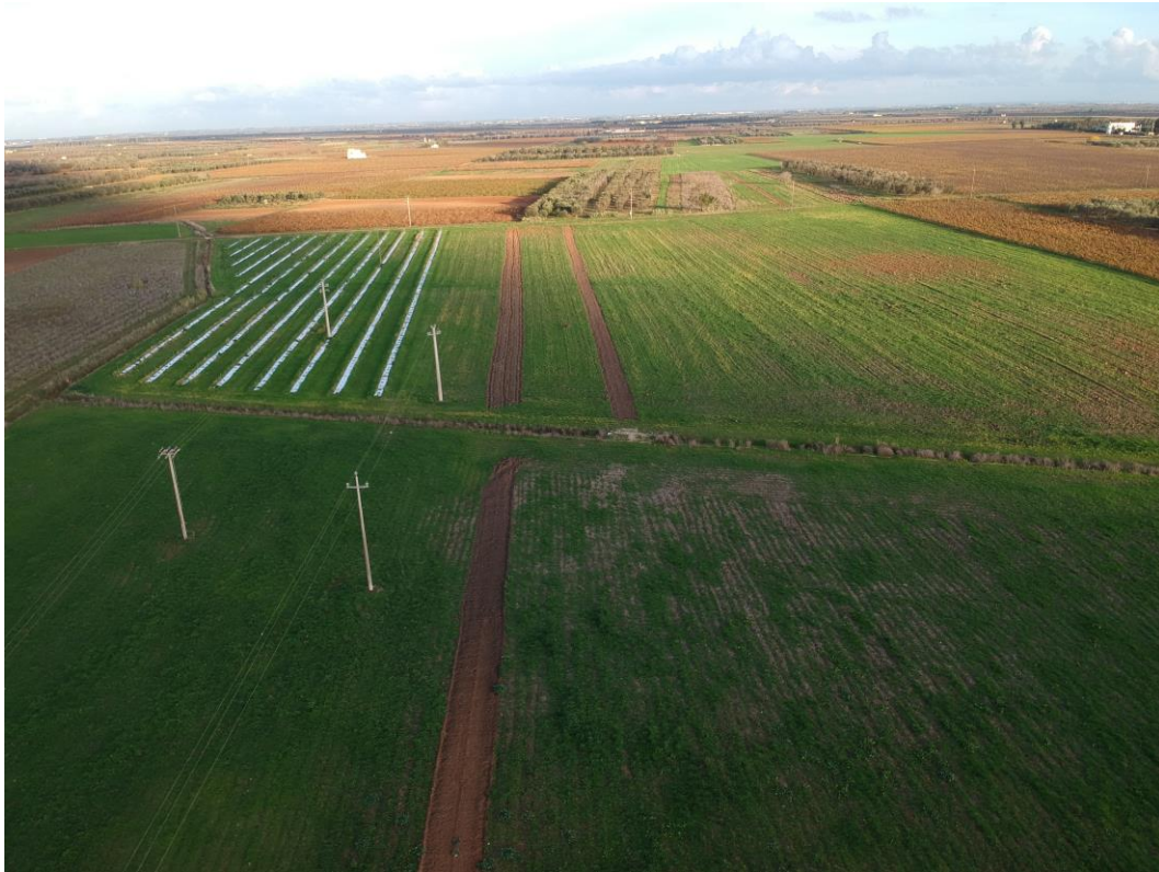
Figura P13 - Vista del percorso del cavidotto e dell'area di localizzazione della SV06 dalla Strada Provinciale 109
