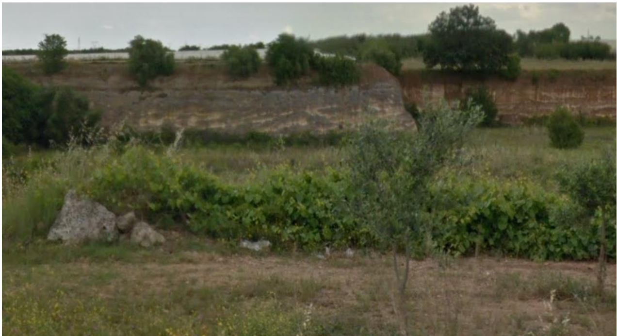
Figura 7: Calcareniti di Gravina: scavo di fondazione localizzato a nord dell'area in studio.
