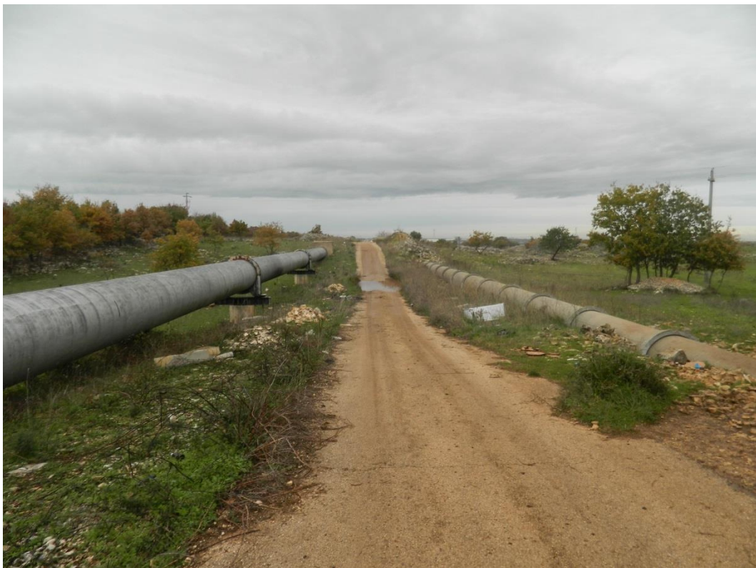
Foto n. 3: la strada di proprietà dell'AQP con la condotta idrica sopraelevata
