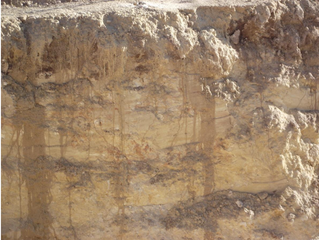
Figura 7: Calcareniti di Gravina: scavo di fondazione localizzato a nord dell'area in studio.
