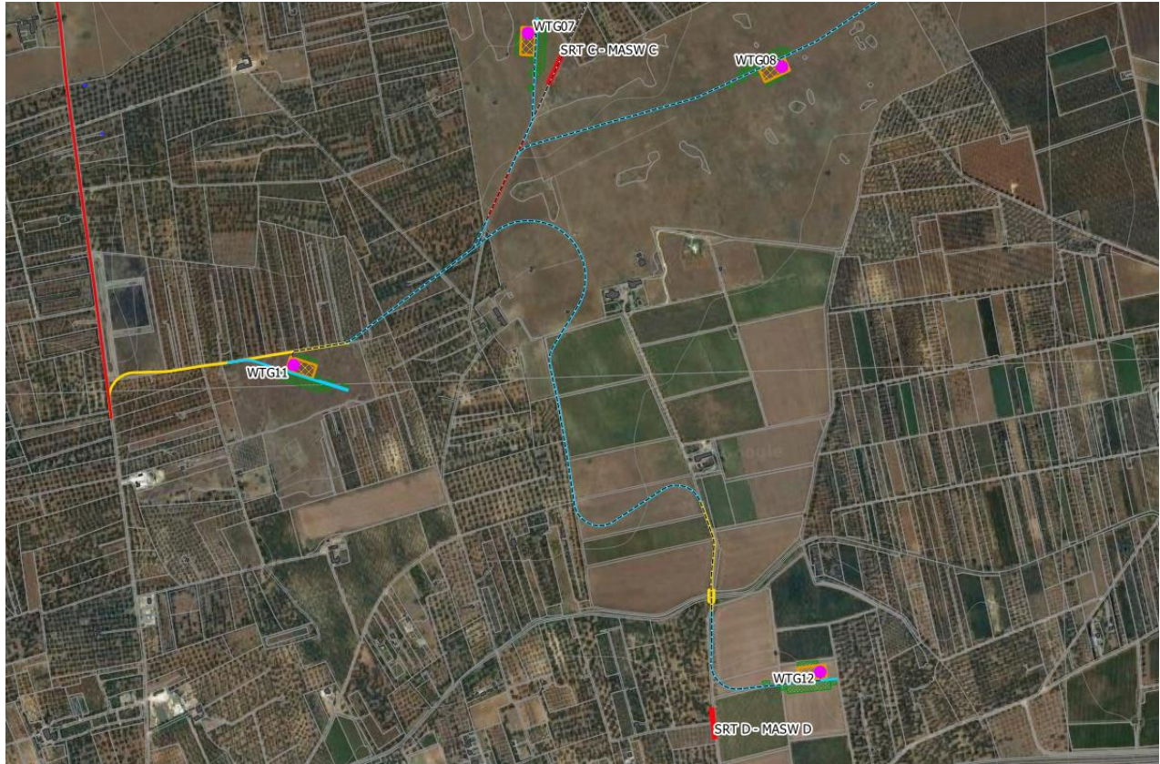
Figura 15: Ubicazione indagini geofisiche.
