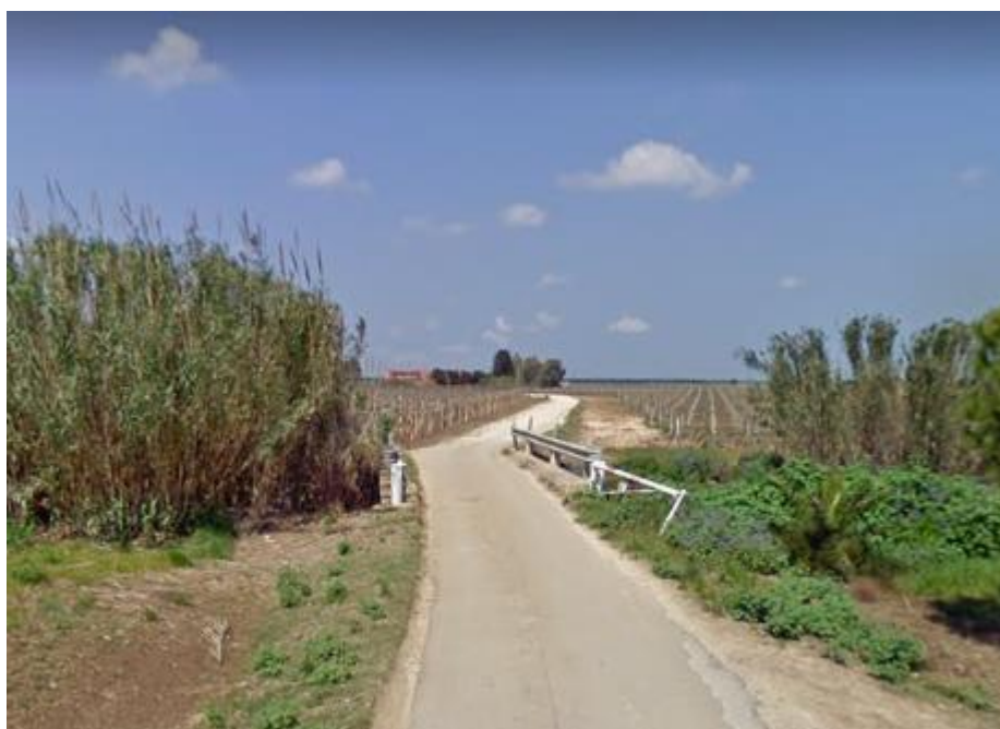
Figura 12 - Attraversamento esistente del Canale Reale, previsto miglioramento della viabilità
