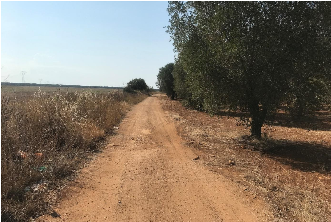
Figura 57 Strada esistente da adeguare per raggiungere le WTG01, 02, 05 e 06
