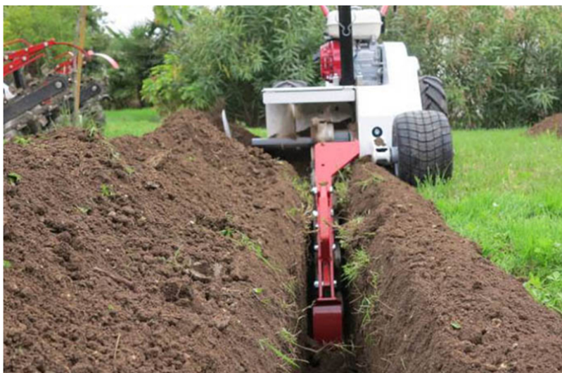
Figura 23: Particolare operazioni di scavo a sezione obbligata.
