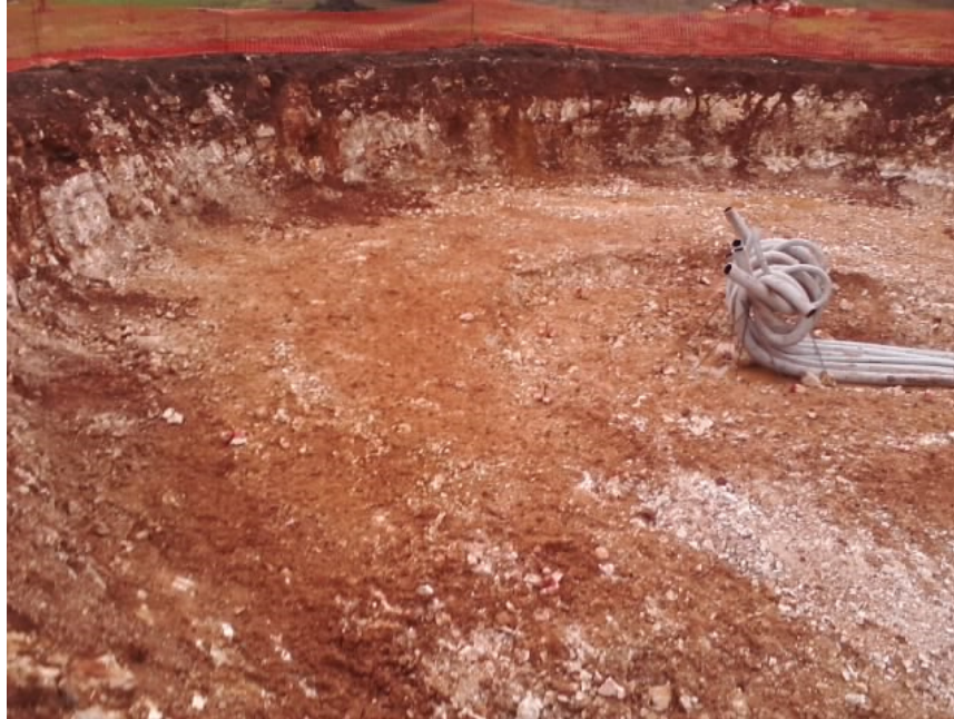
Figura 22: Particolare scavo di sbancamento per fondazioni WTG.
