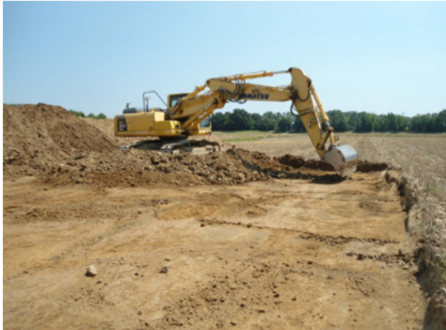
Figura 21: Particolare operazioni di scotico del terreno superficiale.
