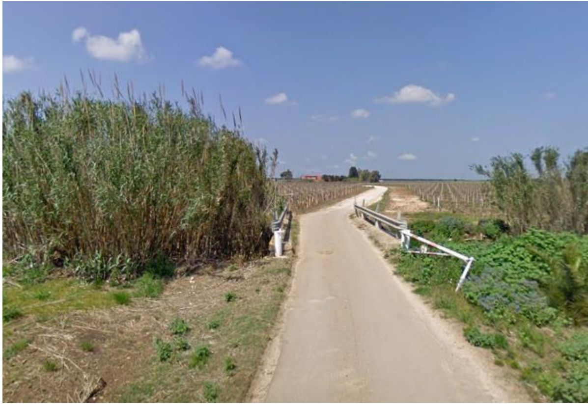
Figura 16 - Attraversamento esistente del Canale Reale, da adeguare per l'impianto eolico in progetto
