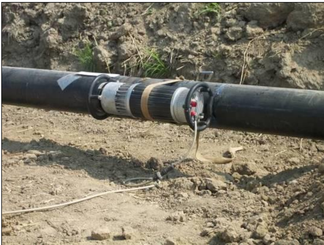
Fig. 1.2.6- Controlli non distruttivi delle saldature
