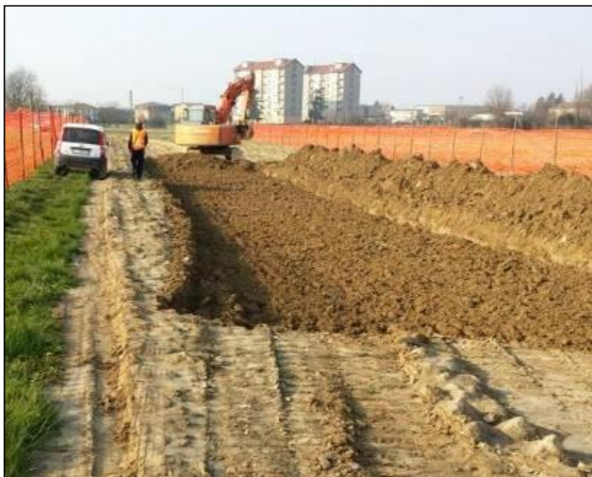
Fig. 1.2.2: Apertura della pista di lavoro
