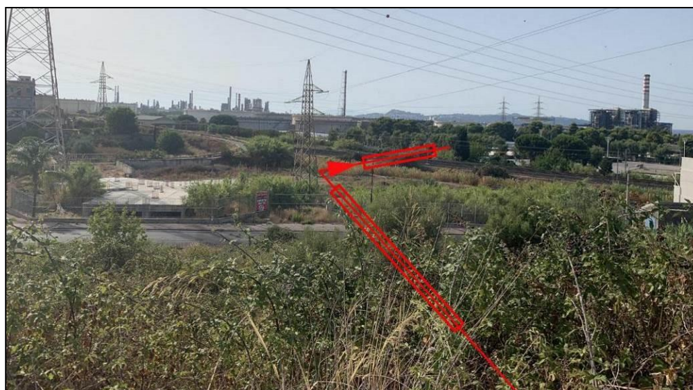
Foto 1/U – Panoramica senso gas degli attraversamenti della S.S. N.113 e della Ferrovia Messina-Palermo in trivellazione
