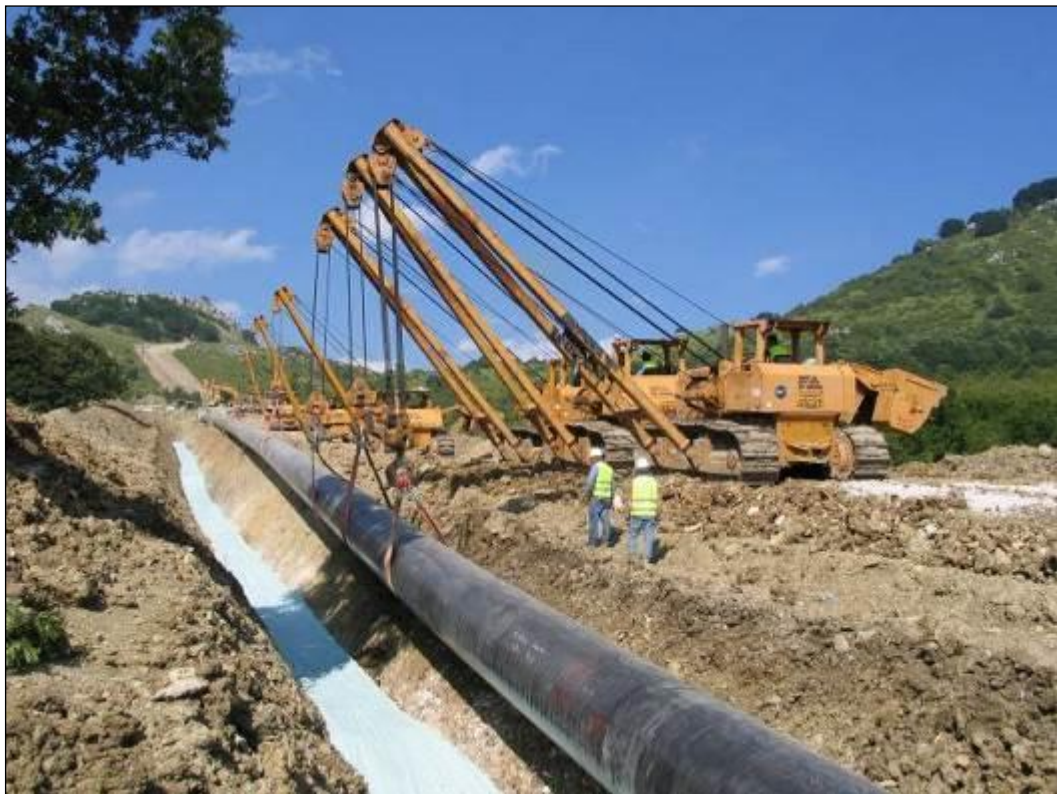
Fig. 1.2.9 - Posa della condotta
