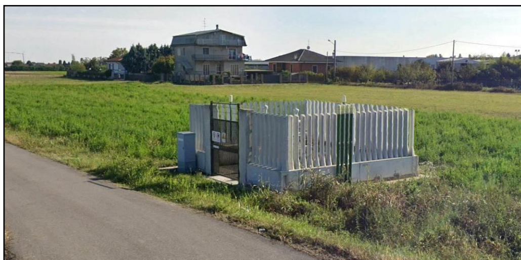
Fig. 1.2.12/B: Installazione tipo impianto di linea con recinzione in pannelli in cls prefabbricati
