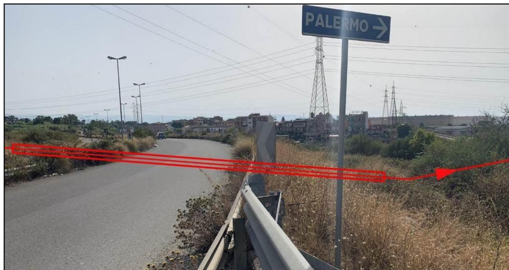
Foto 1/T – Vista dell' attraversamento dell'asse viario Zona Industriale in trivellazione
