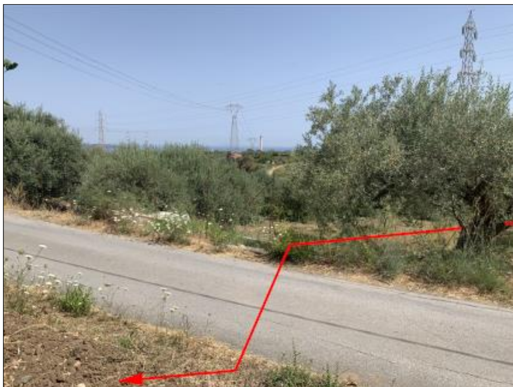
Foto 1/F – Vista contro senso gas dell'attraversamento strada comunale in Contrada Sant'Agata
