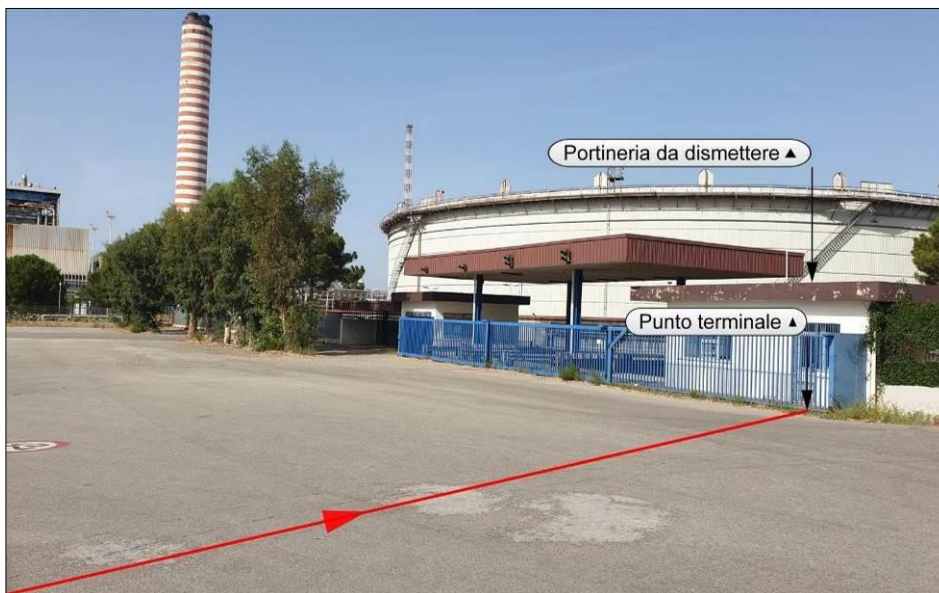
Foto 1/V – Vista piazzale della centrale di San Filippo del Mela con ubicazione area impianto PIDA/C km 4+998
