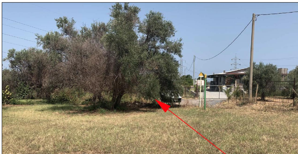
Foto 1/G – Vista senso gas dell'attraversamento strada comunale in prossimità Frantoio Mastroeni
