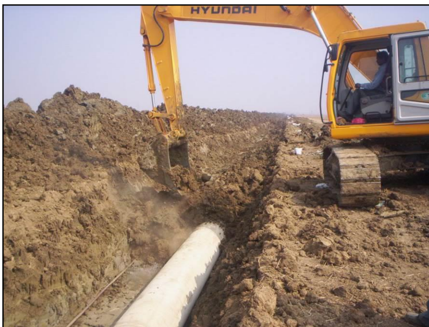
Fig. 1.2.10 - Rinterro della condotta
