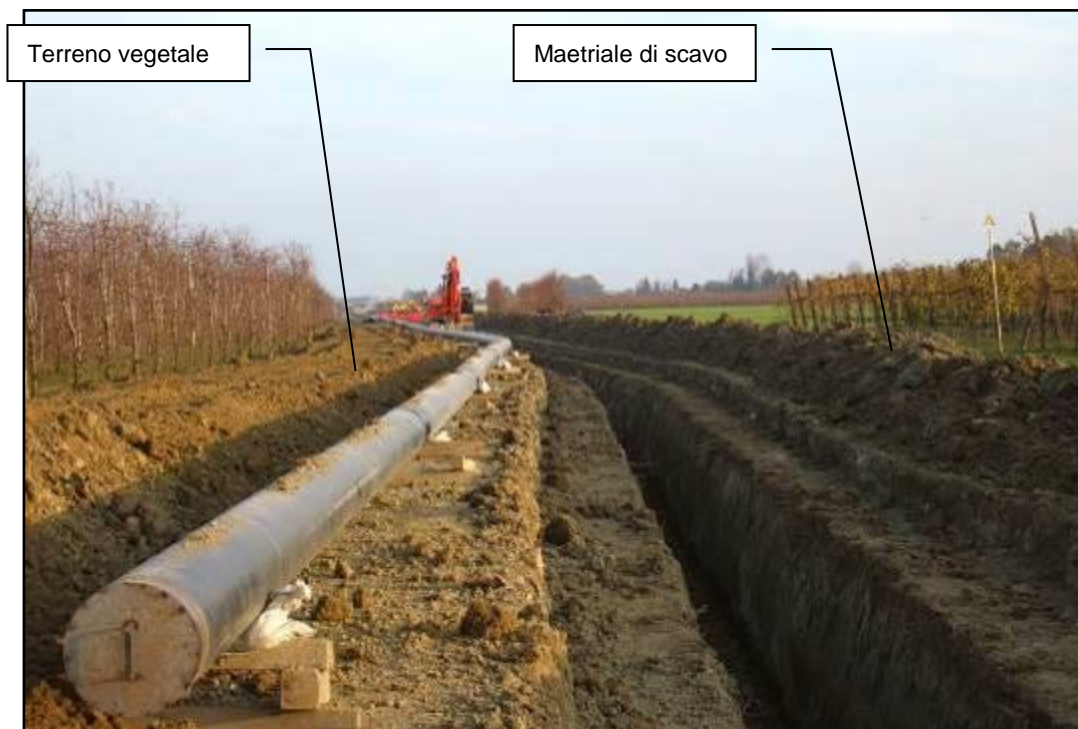
Fig. 1.2.7 - Scavo della trincea
