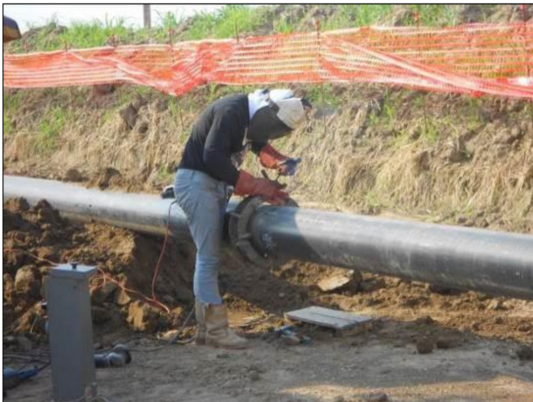
Fig. 1.2.5 Saldatura della tubazione
