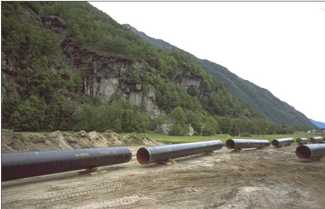
Fig. 1.2.4 - Sfilamento tubi
