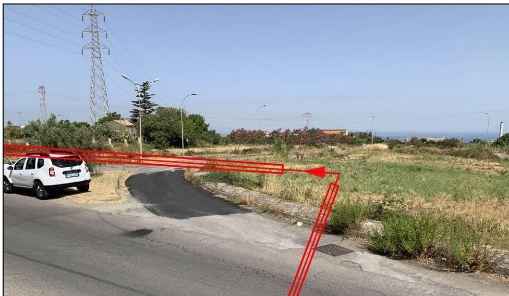
Foto 1/D – Vista senso gas dell'attraversamento della strada della Frazione G. Verga in trivellazione e trivellazione area di urbanizzazione
