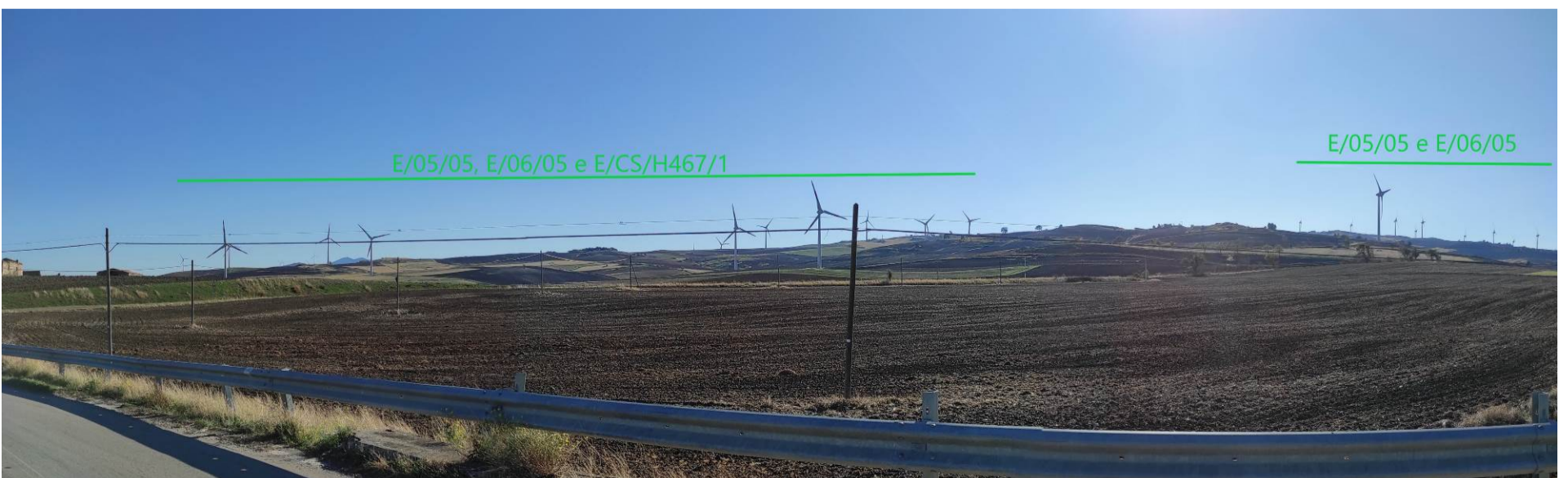
Vista V1_3d ante e post operam (sud-ovest)
