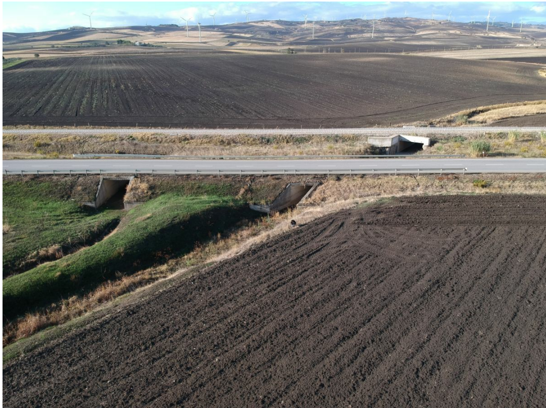
Foto P12: Vista della SS655 e della linea ferrata interessata dal passaggio del cavidotto in prossimità dell'attraversamento del corso d'acqua Fosso del Malo
