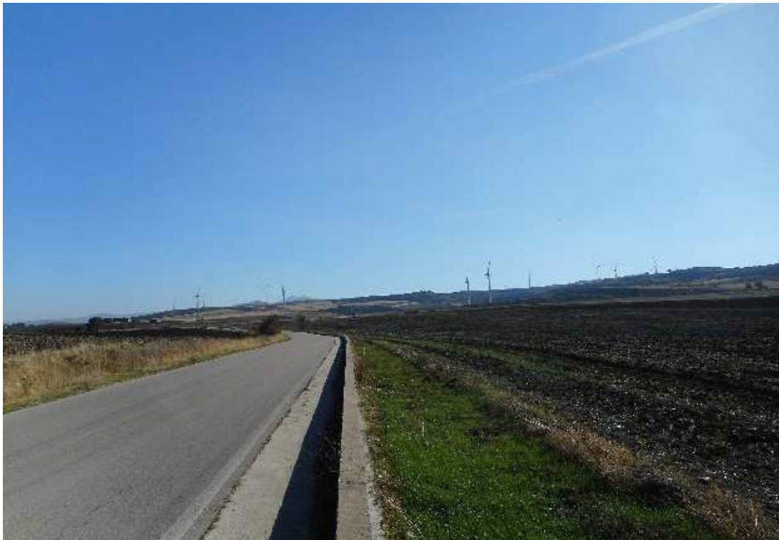
Foto P9: Vista dalla SP98 interessata dal passaggio del cavidotto interno in direzione dell'aerogeneratore WTG03, Località Grotticelle
