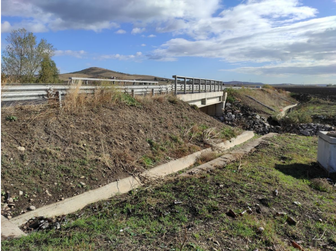
Foto P13_1: Vista della SP97 interessata dal passaggio del cavidotto in prossimità dell'attraversamento del corso d'acqua Rio Salso
