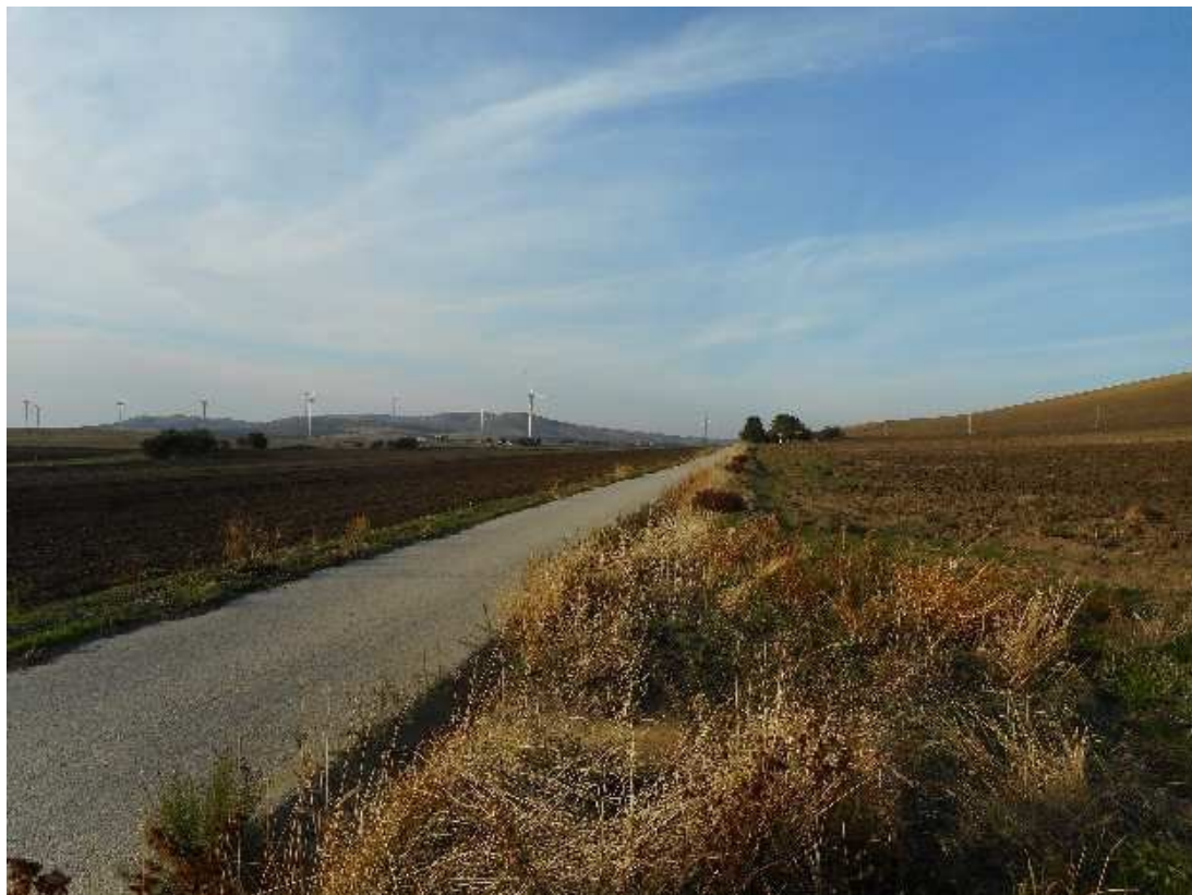
Foto P15: Vista della viabilità secondaria interessata dal passaggio del cavidotto interno, Località Posta Fissa
