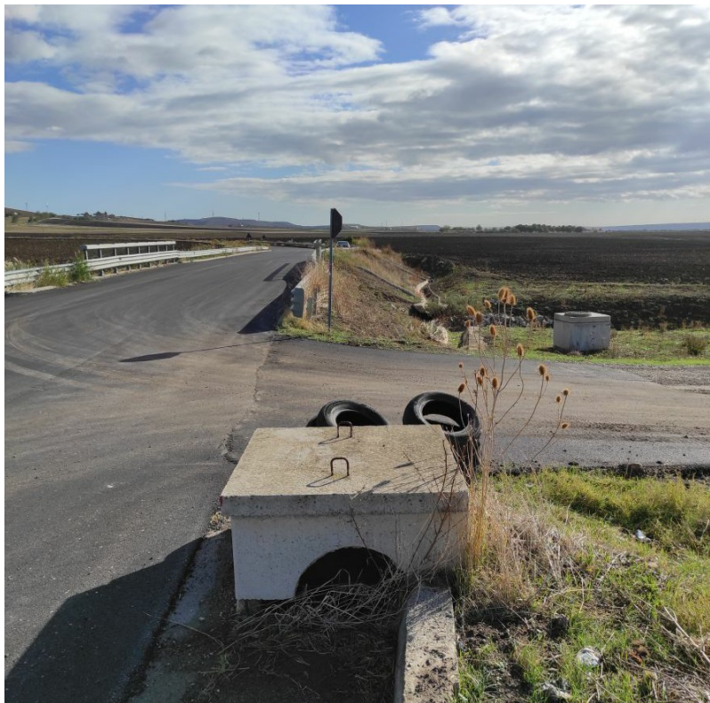
Foto P13_1: Vista della SP97 interessata dal passaggio del cavidotto in prossimità dell'attraversamento del corso d'acqua Rio Salso
