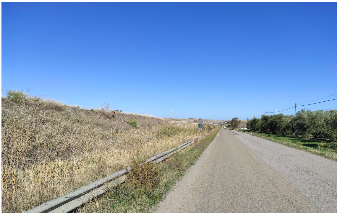
Foto P18_1: Vista dalla SP95 interessata dal passaggio del cavidotto esterno, in direzione della sottostazione NE
