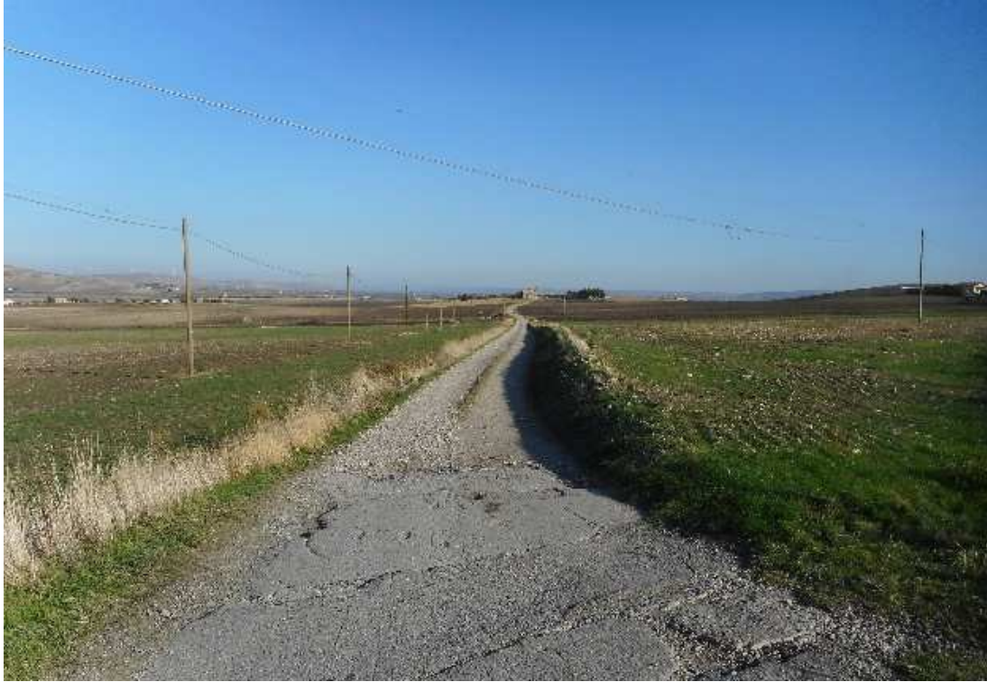
Foto P11: Vista della viabilità secondaria interessata dal passaggio del cavidotto interno in direzione dell'aerogeneratore WTG04, Località Masseria Bascianelli
