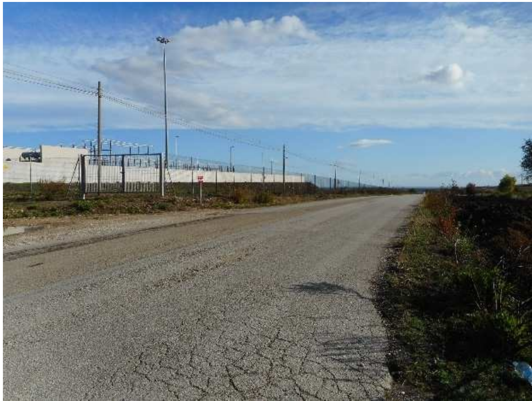
Foto P19_1: Vista dalla SP 95, interessata dal passaggio dell'ultimo tratto del cavidotto esterno, in prossimità della stazione Terna esistente
