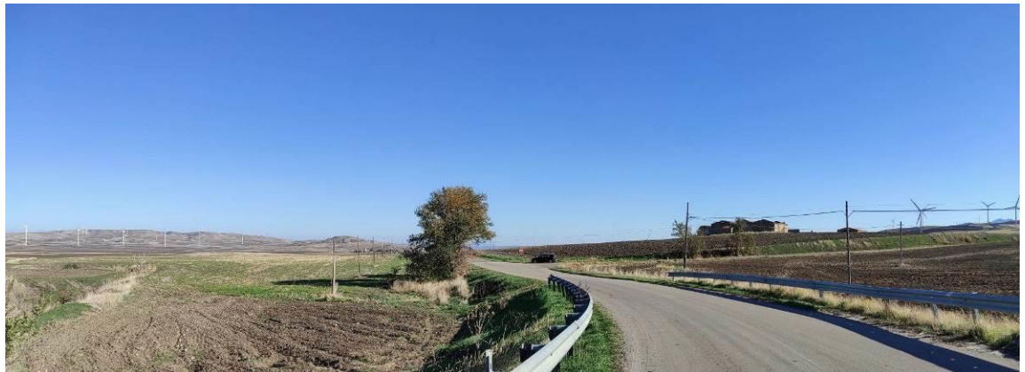
Vista V1_3a ante operam (sud-est)
