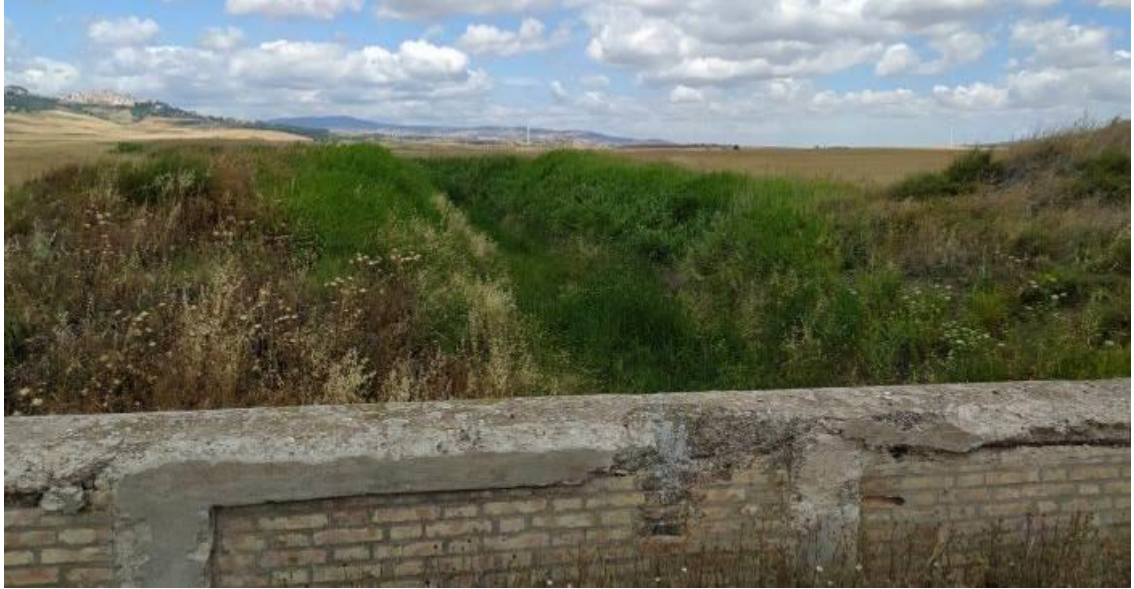
Rio Salso all'interno dell'area di progetto in direzione della turbina C02 e del centro abitato di Candela
