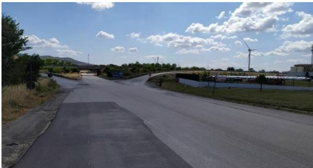
SP 95 in corrispondenza della rampa di accesso alla SS655, a nord dell'area di progetto
