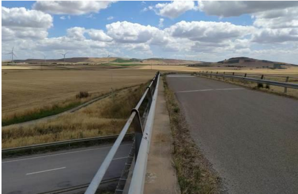
SP 97 in corrispondenza della SS 655
