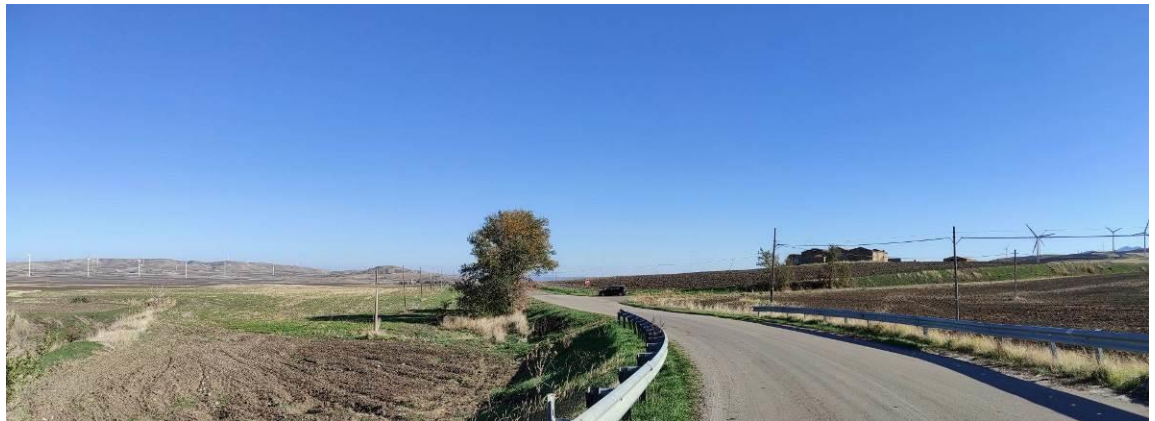
Vista V1_3a ante operam (sud-est)
