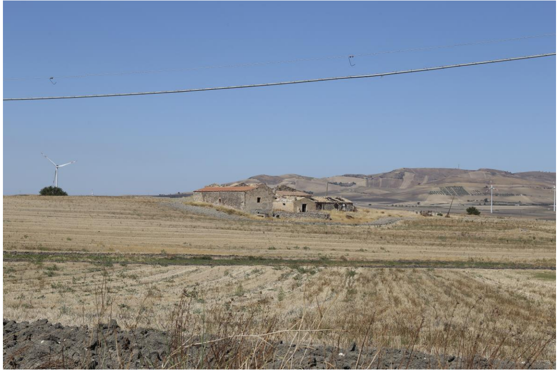
Figura – Masseria Il Casone nell'area indagine, in evidente abbandono e degrado (Foto Studio Rocco Carella).
