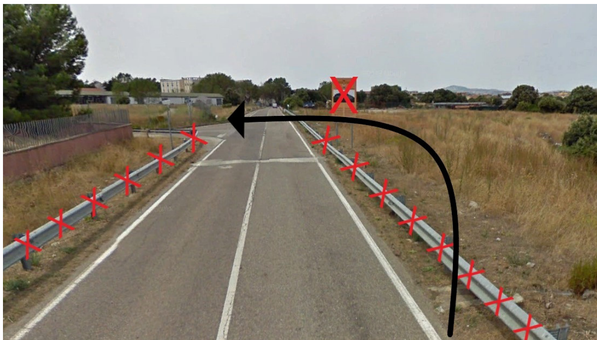
Fig. 54 – Vista frontale ingresso sud Perdasdefogu
