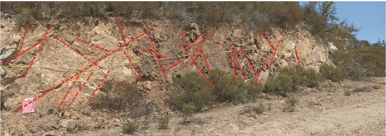
Figura 7. 5: Vista sull'affioramento della Fm. S. Vito (SVI-2) con tracce dei giunti di fratturazione.
