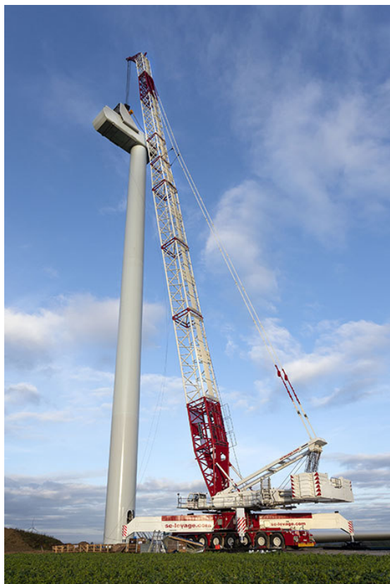
Figura 13 – Una gru tipo Liebherr 1750 durante l'installazione di un generatore eolico
