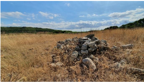
Figura 75. UT S'Accorradroxiu, depositi di crollo.
