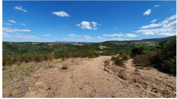
Figura 87. Tracciato del cavidotto presso WTG001, vista da SW.
