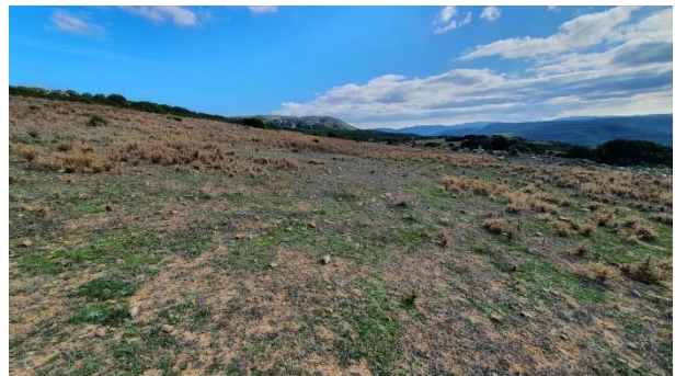
Figura 99. Tracciato del cavidotto presso WTG012, vista da NW.
