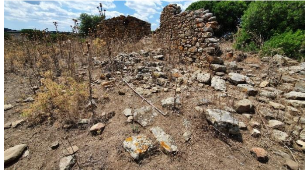
Figura 43. UT Gutturu Luas, affioramenti murari pertinenti a strutture antiche.
