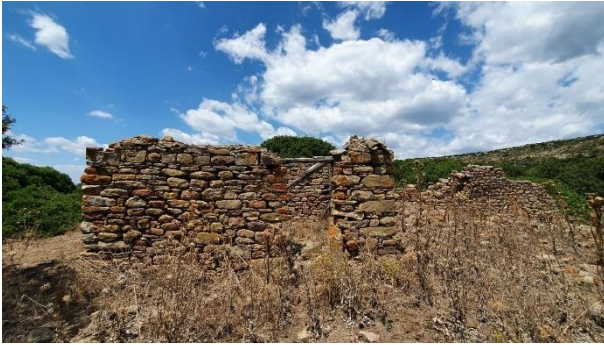
Figura 34. Su Coili de Sorrosu, vista da SE.
