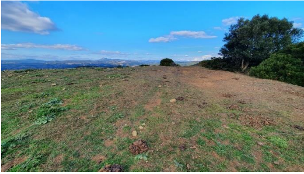
Figura 64. Area della turbina WTG011, vista da SE.
