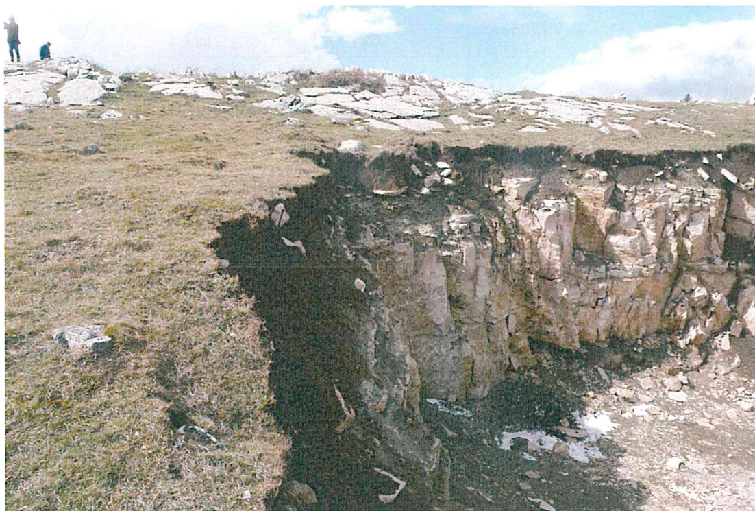
Foto 10 – La collinetta con i pavimenti calcarei (habitat di Direttiva 8240*) della foto 9 tagliata da uno sbancamento per realizzare un'area di manovra e/o stoccaggio
