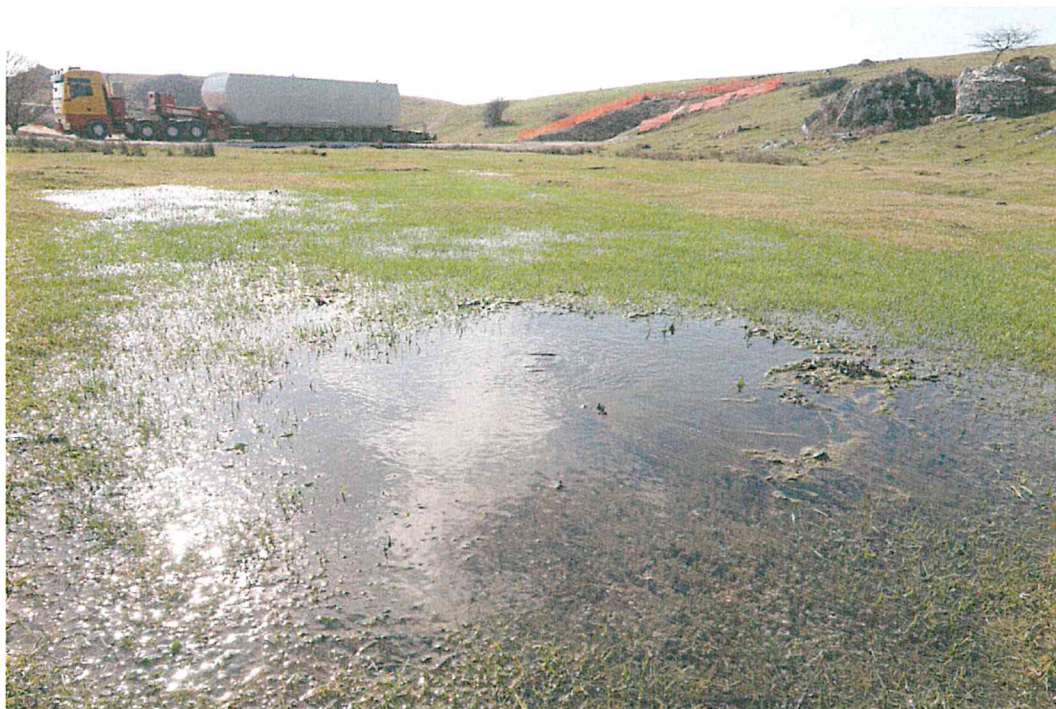
Foto 13 - L'ambiente umido di risorgiva tagliato e tombato per realizzare una area di manovra
