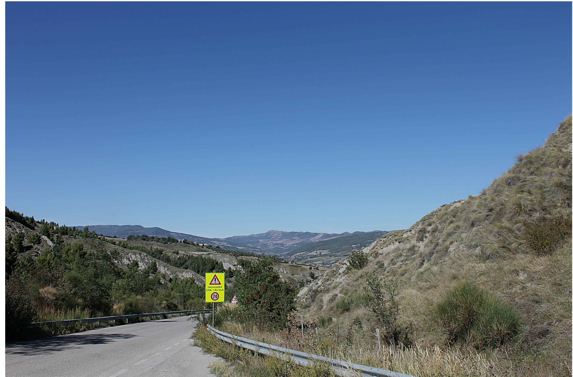
F11.ARMENTO - Punto panoramico lungo la strada: Stato di fatto
