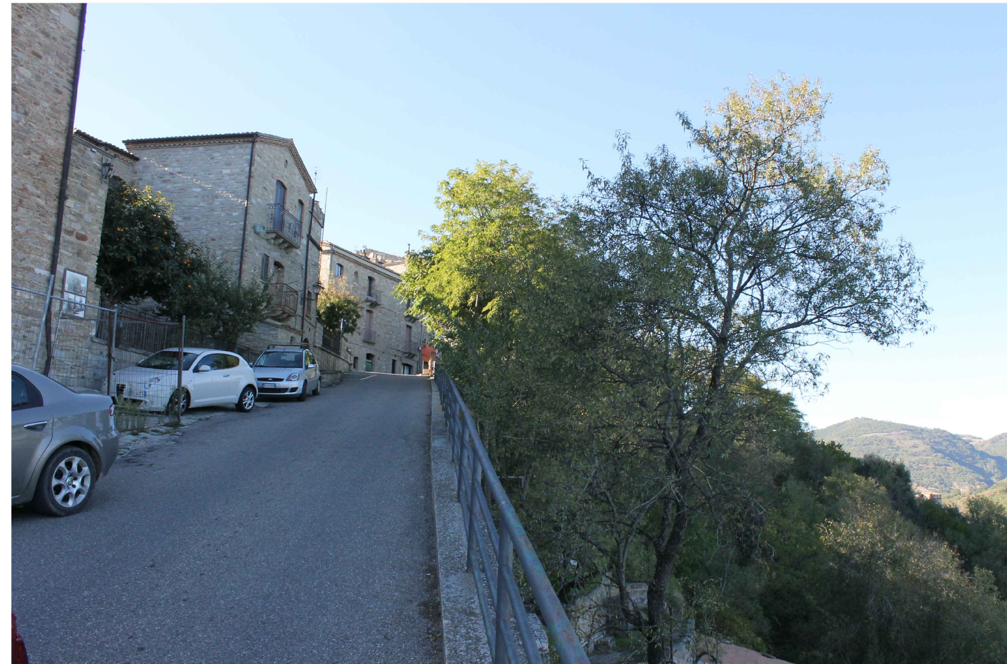
F10.GUARDIA PERTICARA - Strada interna al centro abitato: Stato di fatto
