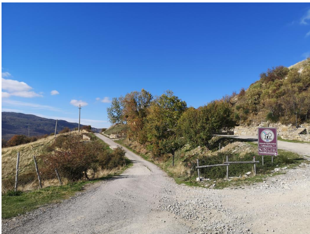
Foto 31. WTG 1 + Cavidotto interno. Strada di accesso. Vista da NW.
