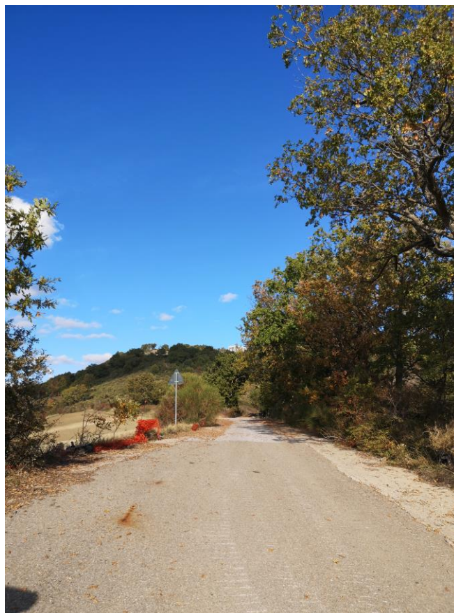
Foto 28. Cavidotto-S.Comunale s.n. c/o WTG6
