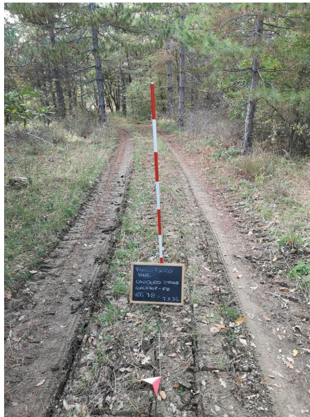
Foto 61. WTG 7. Strada d'accesso/cavidotto interno.
