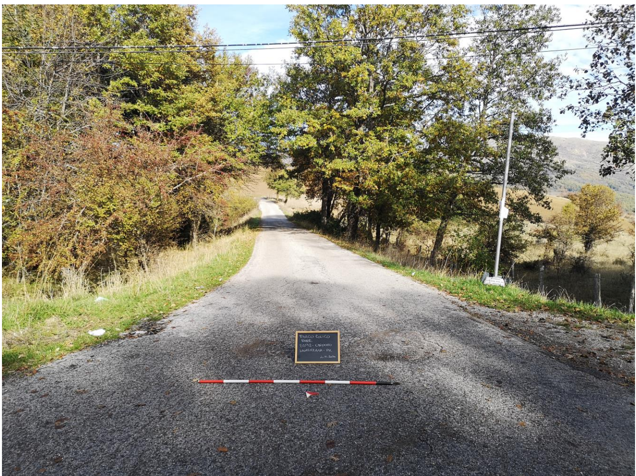
Foto 8. Cavidotto: tratto iniziale verso la SSE – Strada Comunale s.n.. Vista da SW.
