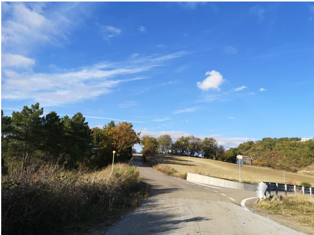
Foto 29. Cavidotto-S.Comunale s.n. Verso WTG 7/8
