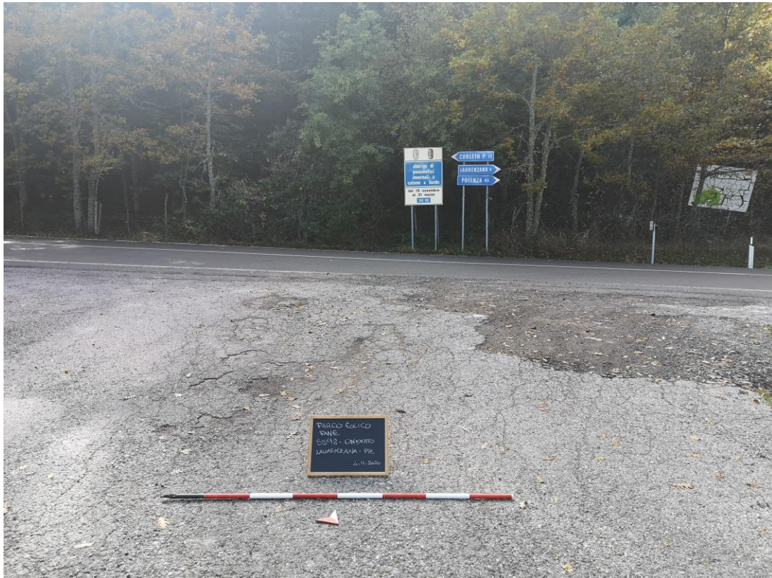
Foto 9. Cavidotto. Inizio del cavidotto lungo la SS92. Vista da NE.
