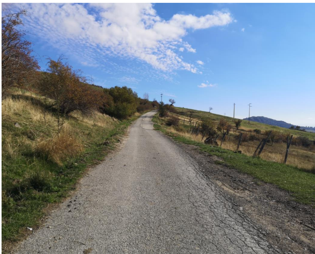
Foto 32. WTG 1 + Cavidotto interno. Strada di accesso. Vista da NW.
