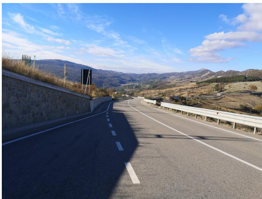
Foto 26. Cavidotto-S.Comunale s.n.-interferenza con area di vincolo Peticara
