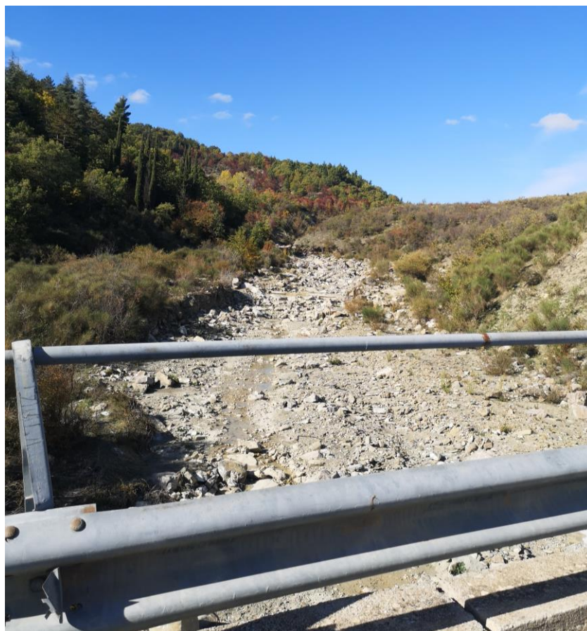
Foto 18. Cavidotto-S.Comunale s.n., attraversamento Fiumarella di Corleto
