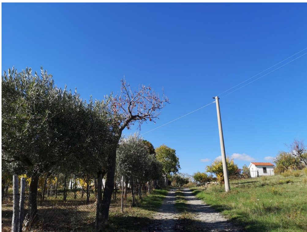
Foto 22. Cavidotto-S.Comunale s.n.-diramazione WTG 2-3
