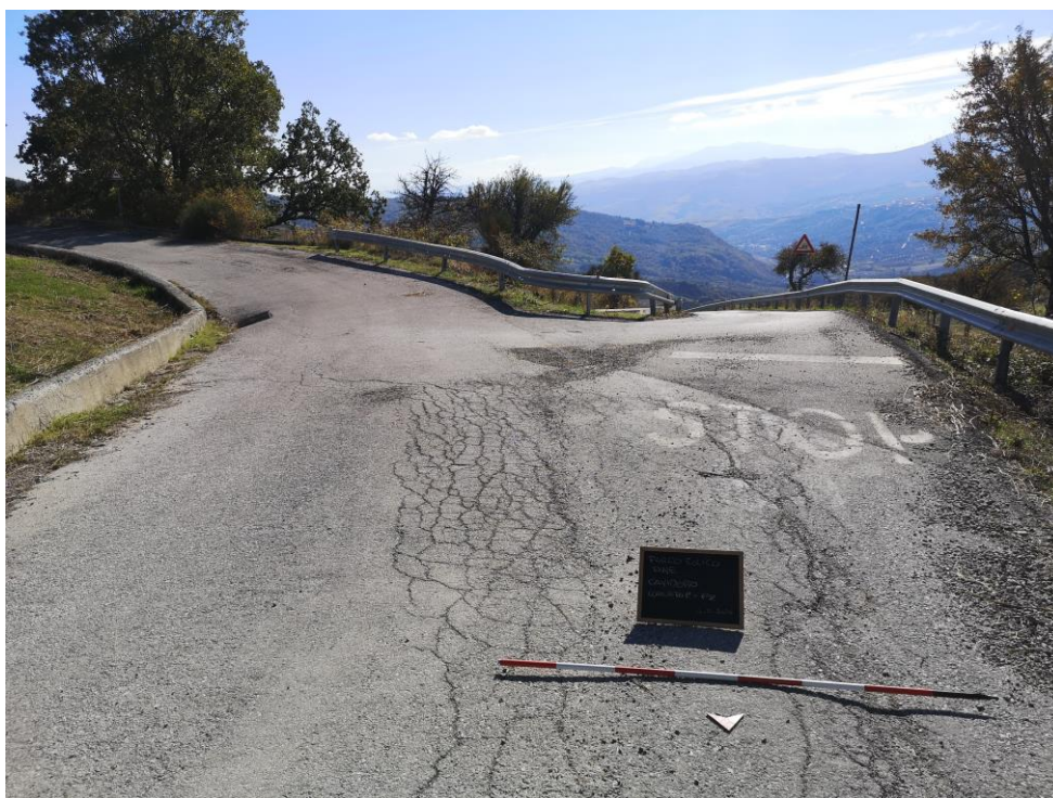
Foto 19. Cavidotto-S.Comunale s.n.-diramazione verso Pozzo Peticara 1 e per WTG 2-3
