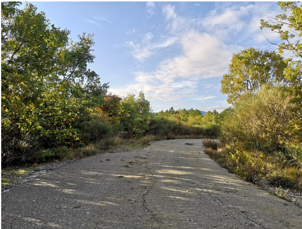
Foto 70. WTG 8. Strada d'accesso/tratto finale cavidotto.
