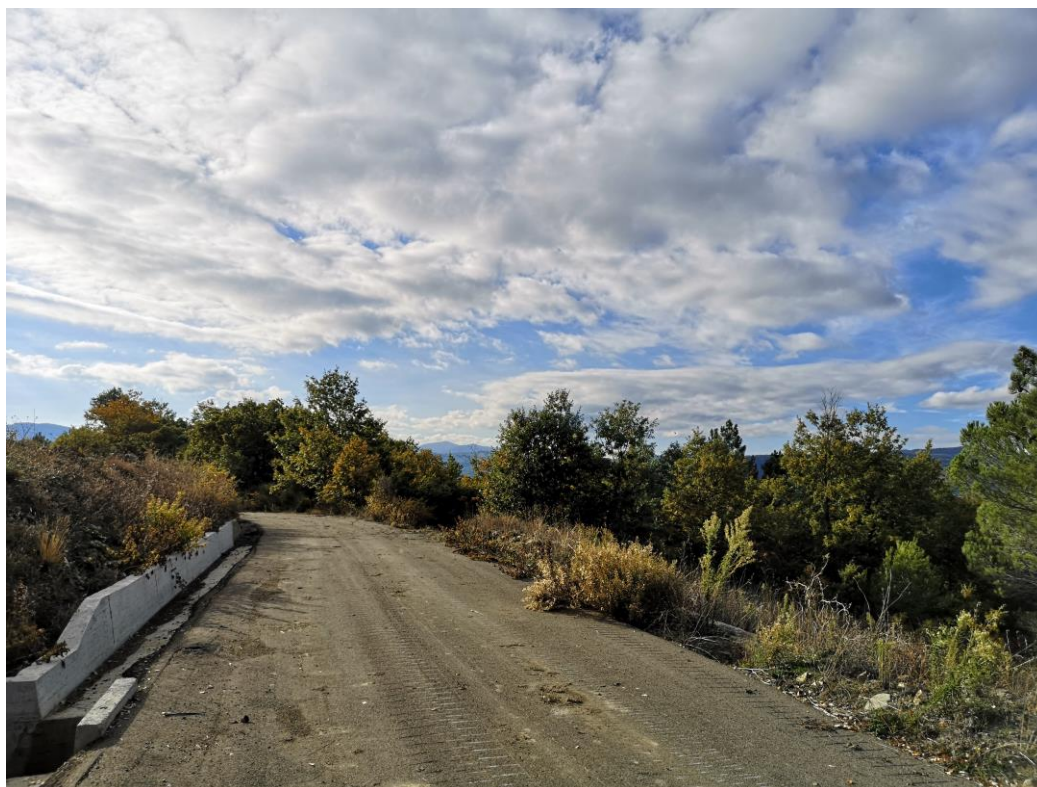
Foto 30. Cavidotto-S.Comunale s.n.-Tratto finale verso WTG 7-8
