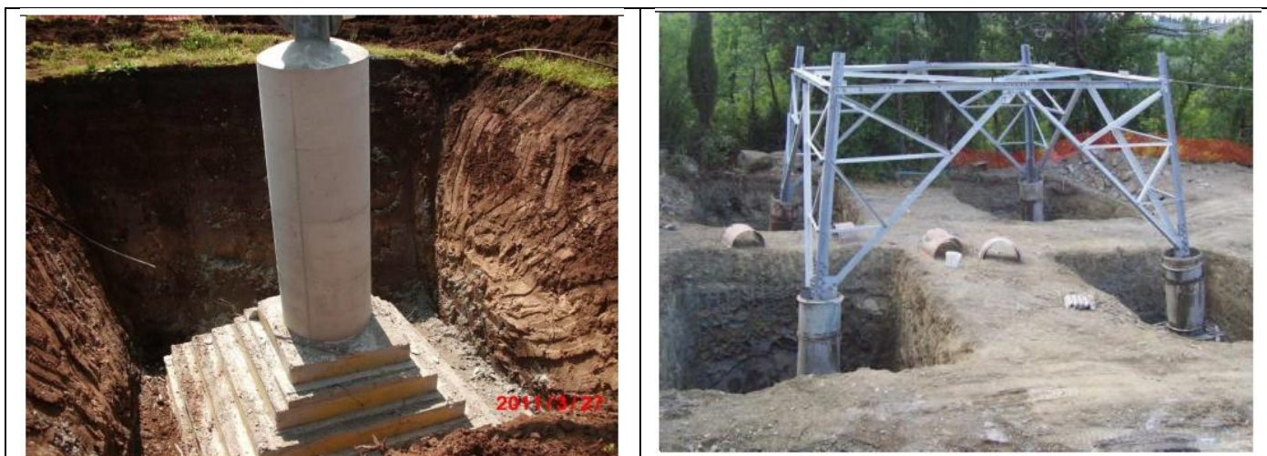
Figura 54: Realizzazione di fondazioni superficiali tipo CR per un sostegno a traliccio
