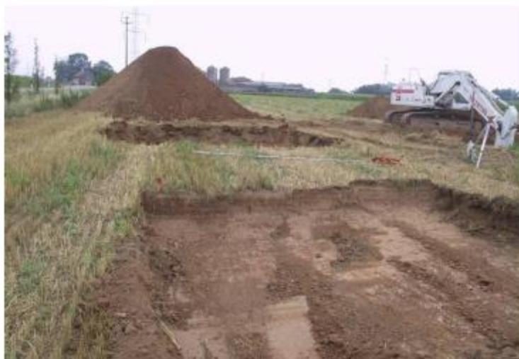
Figura 46: Esempio di fase di tracciamento e scotico terreno di un micro-cantiere
