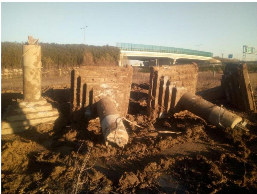
Figura 53: Esempio di rimozione della fondazione superficiale di un sostegno 220 kV
