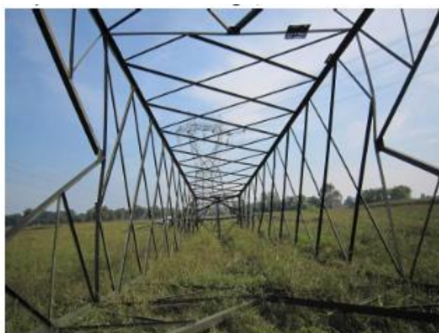
Figura 52: Fasi demolizione di un sostegno a traliccio
