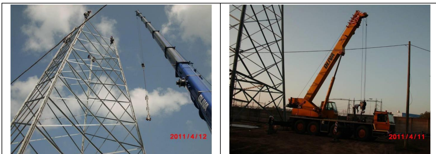
Figura 55: Fasi di montaggio sostegno a traliccio
