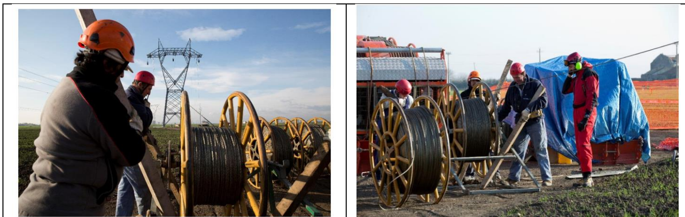
Figura 56: Fasi di tesatura di una linea elettrica, TERNA
