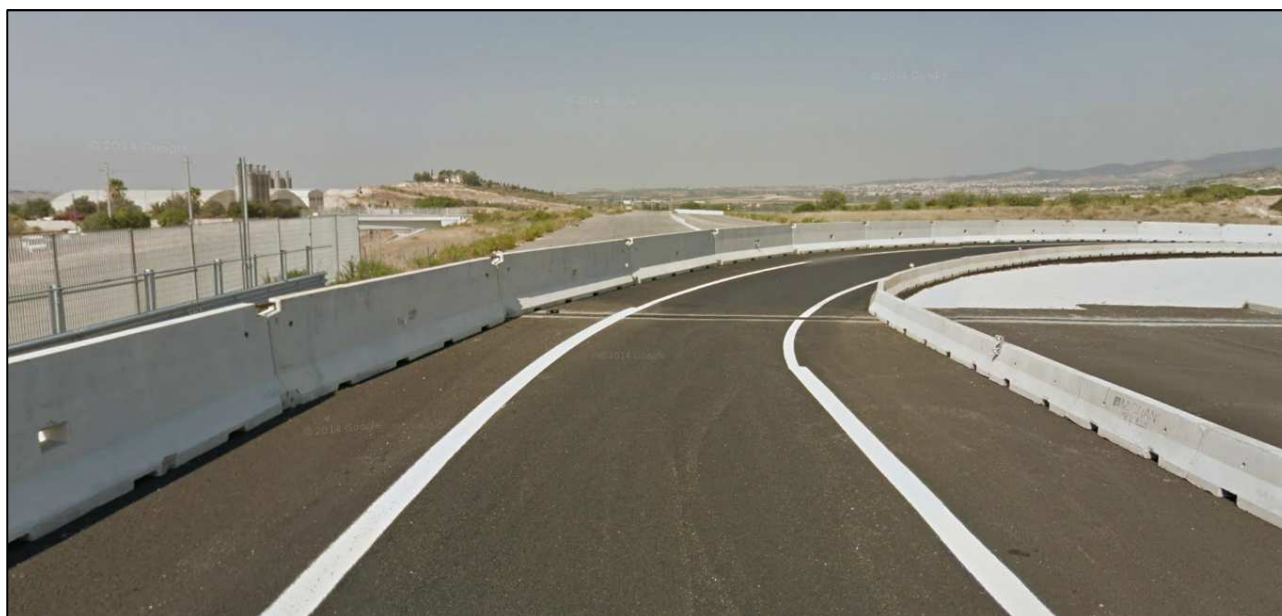
Figura 7 - Interruzione SS 554 BIS
