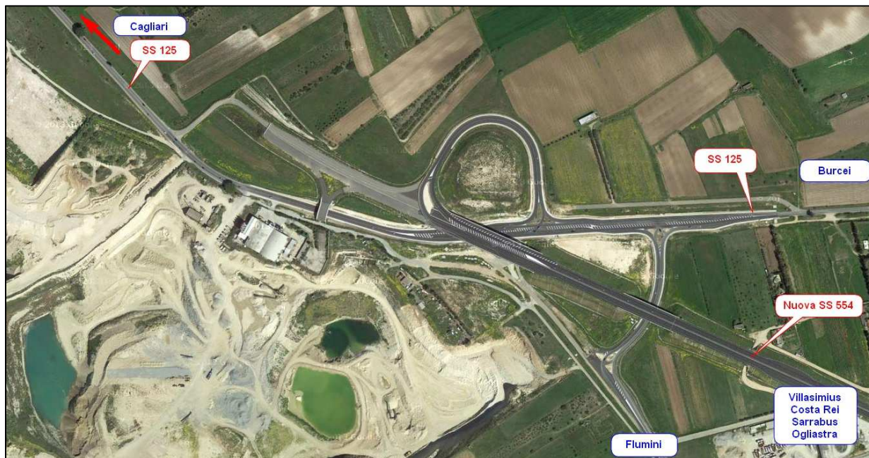
Figura 6 - Svincolo SS125 - SS 554 Bis
