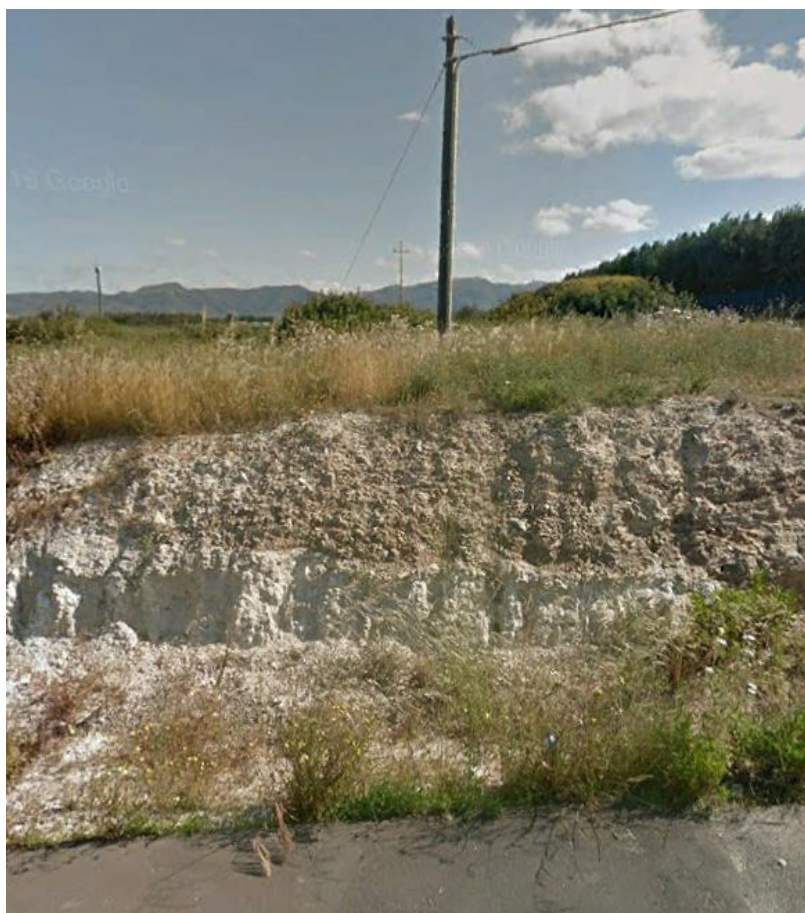
Contatto tra le alluvioni terrazzate e le Marne di Gesturi lungo la SP94 a monte dell'Hotel "I Ginepri"
