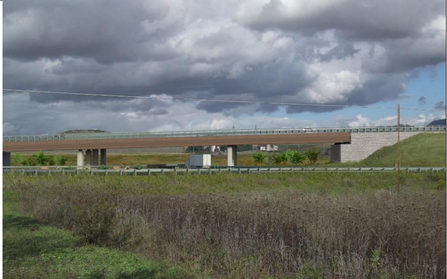
Figura 9-2 Esempio di intervento di tipo architettonico in corrispondenza di muri presenti alle spalle del viadotto
