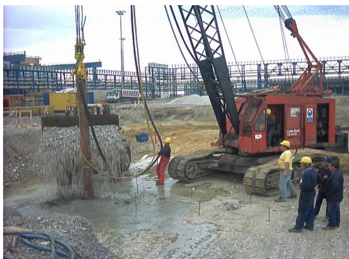
Figura 10 – Foto dell'attività di vibroflottazione presso la centrale Enel di Termini Imerese (PA) nell'area delle fondazioni di turbina.
