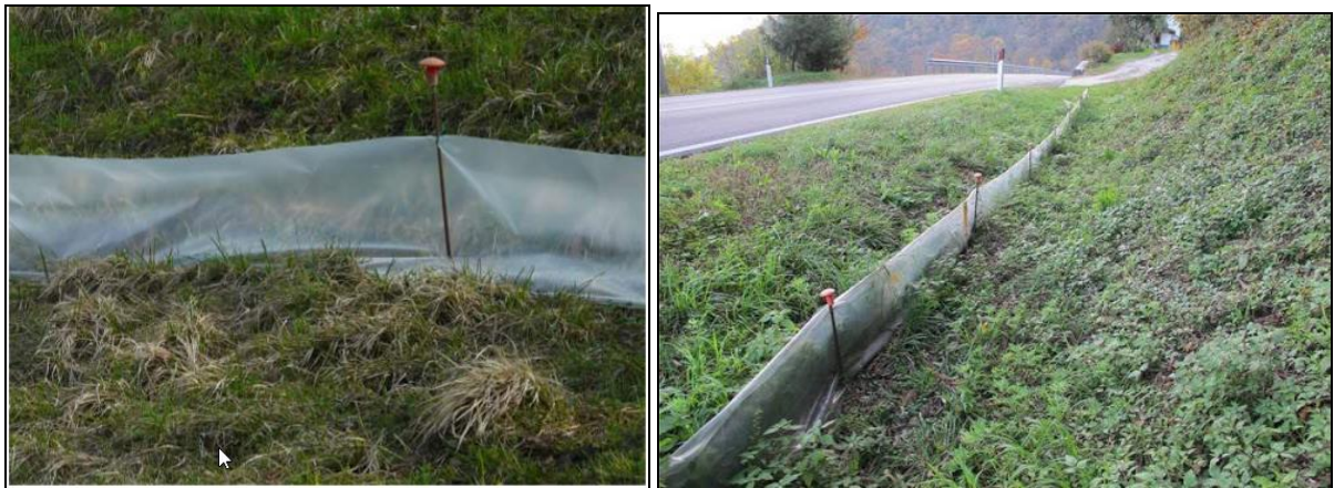
Fig. 11/d – Barriera per erpetofauna esempi con telo in polietilene fermato da picchetto in ferro ed ancorato al terreno con filo di ferro e ganci ad "U" rovescio
