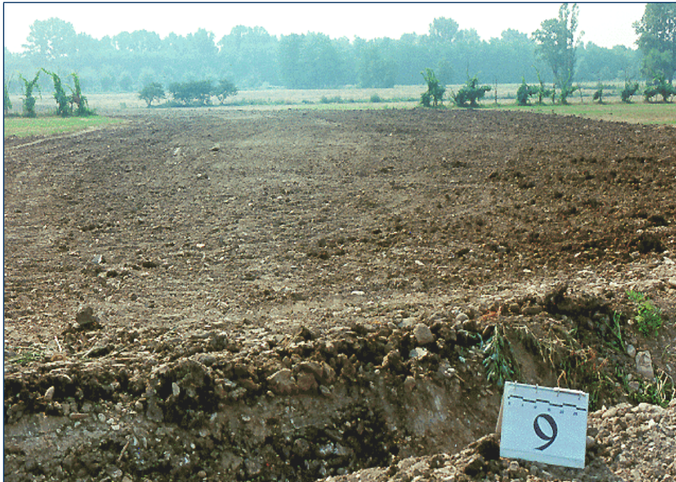
Foto 23 – Livellamento terreno vegetale
