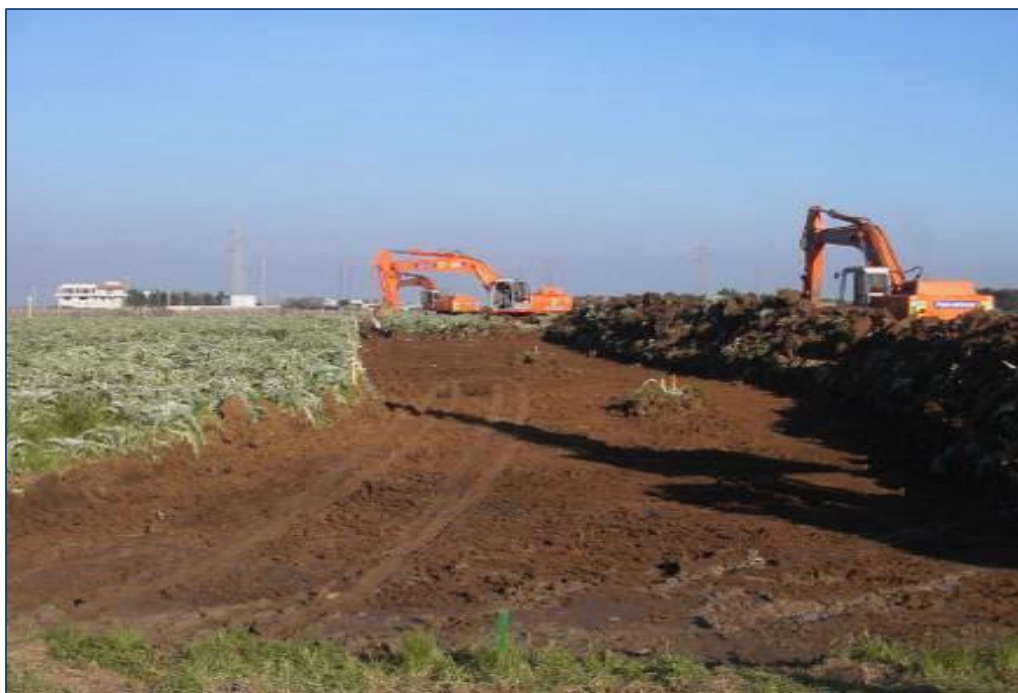
Foto 22 – Apertura area di passaggio scotico ed accantonamento terreno vegetale "humus"
