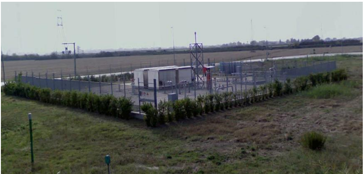
Foto 26 – Es. Mascheramento impianto
