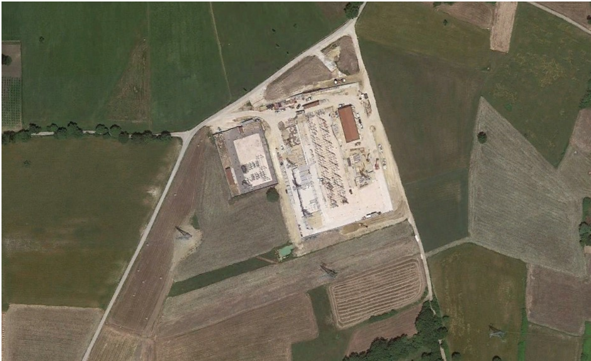
Figura 5. opere elettriche per il collegamento alla RTN già realizzate.
