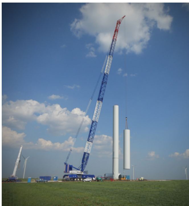
Figura 23 Sollevamento, posizionamento e fissaggio dei tronconi intermedi
