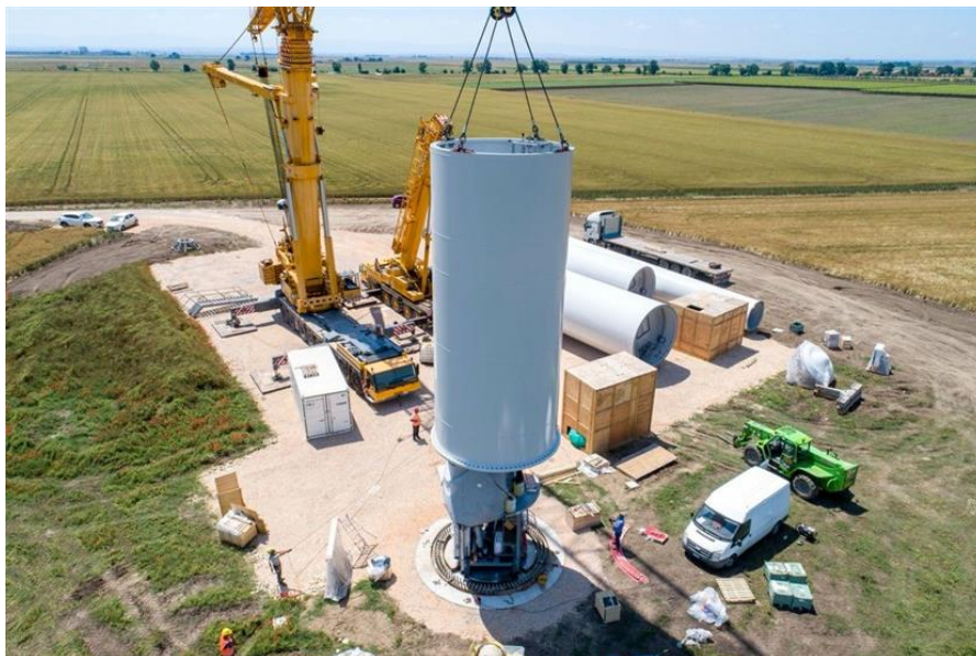
Figura 22 Sollevamento e posizionamento alla fondazione della parte inferiore della torre
