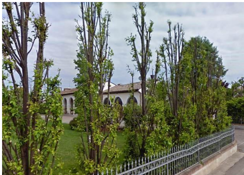
Edificio Storico – Testimoniale sito in via Canale Volpago del Montello
