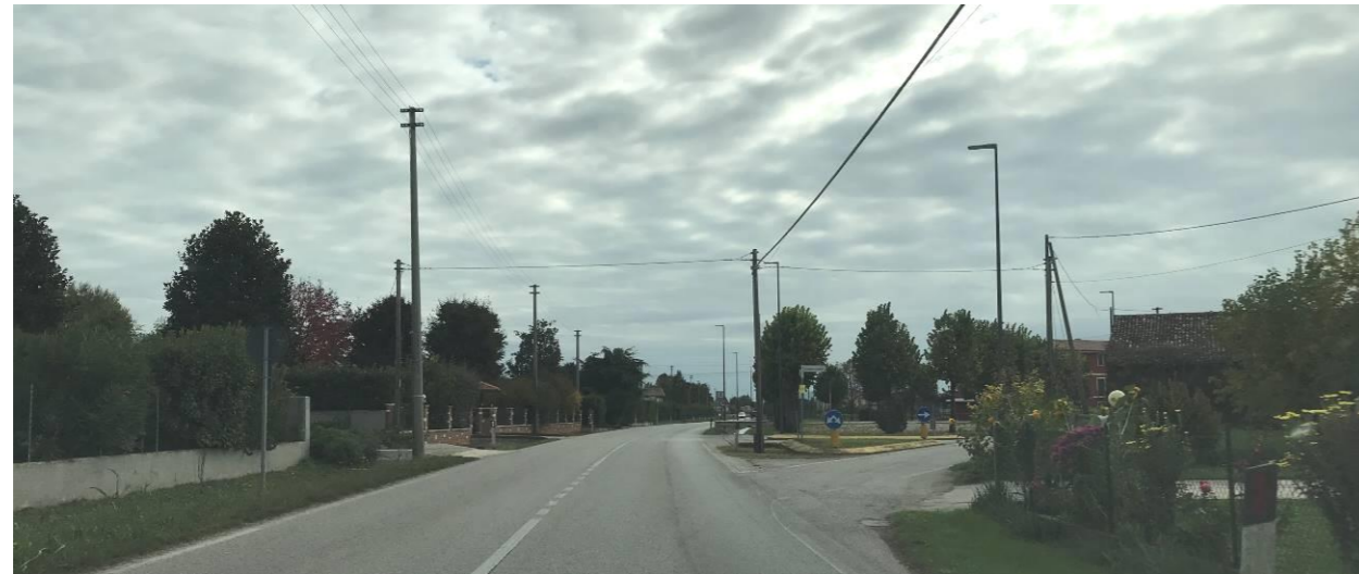
01 Vista lungo via Lavaio verso incrocio con via Fornace vecchia
