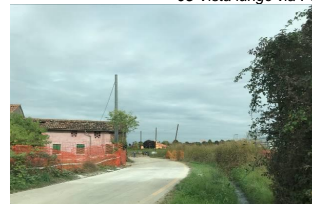
09 Vista lungo via Fornace Vecchia verso nord
