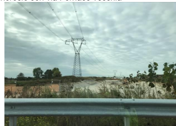
03 Vista da via Lavaio verso lavori SPV
