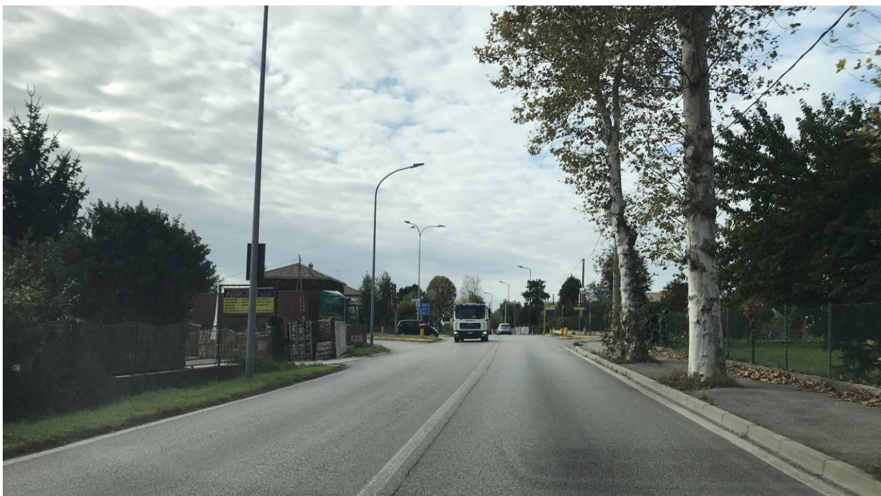
4 - Ambito di intervento visto da Est
