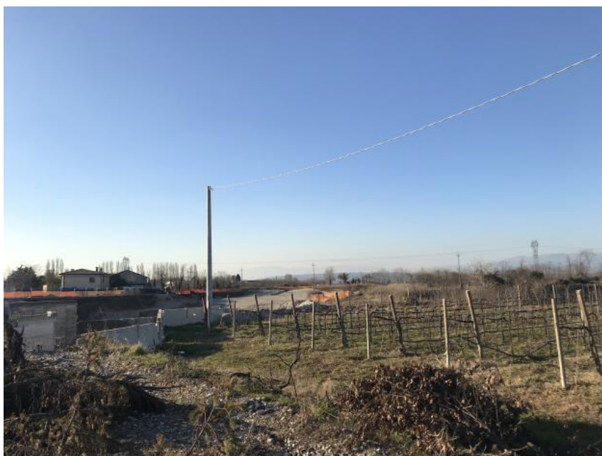
Figura 7. Area interessata dalla viabilità di collegamento tra Via Campagnola.
