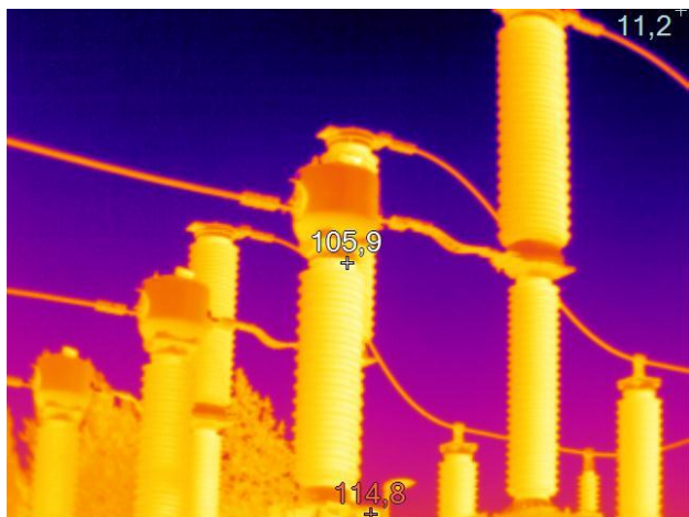
IR_00177.IS2 Vista TA di protezione Interruttore AT
