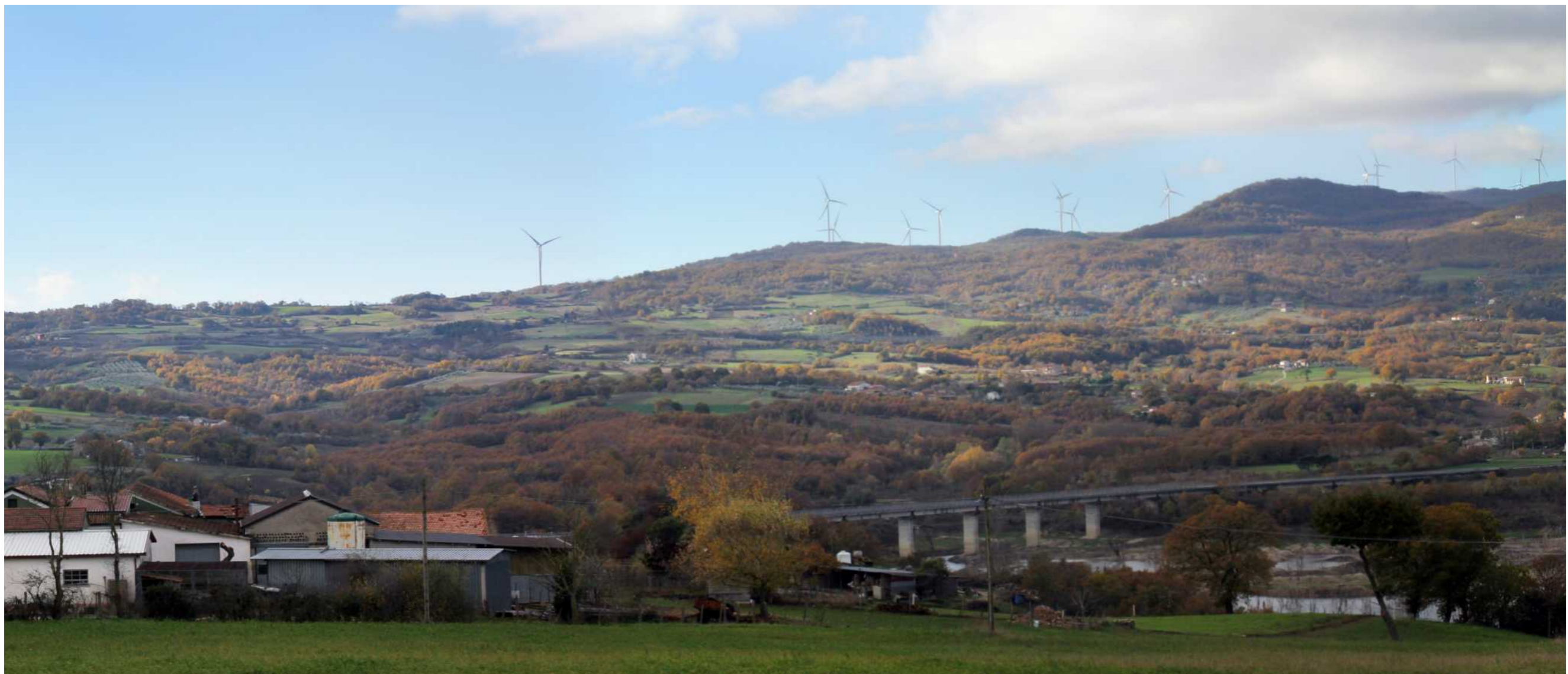
Foto n. 1 ANTE OPERAM 41°20'25.2"N, 14°44'30.7"E
