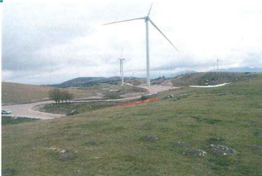
Foto 7 - Prati pascoli afferenti all'habitat di Direttiva 6210 e, potenzialmente, 6210*, interessati, sullo sfondo, dal cantiere del Parco Eolico.
