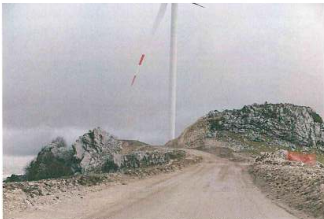
Foto 8 - Taglio della parte sommitale del rilievo calcareo di Ripa Maleportelle, effettuato per consentire il passaggio dei componenti degli aerogeneratori, con distruzione della vegetazione casmofitica ascrivibile all'habitat 8210.
