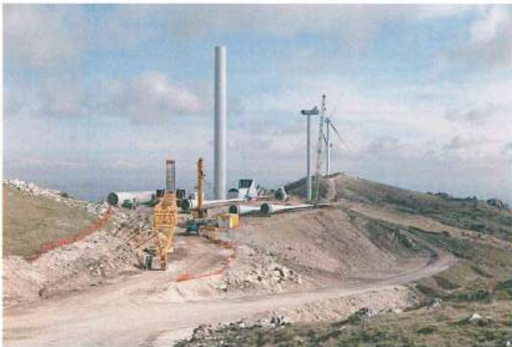
Foto 5 - Spianamento dei versanti e accumulo del materiale sugli habitat di Direttiva 6110*, 6210 e, potenzialmente, 6210*.
