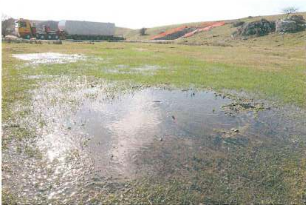
Foto 13 - L'ambiente umido di risorgiva tagliato e tombato per realizzare una area di manovra
