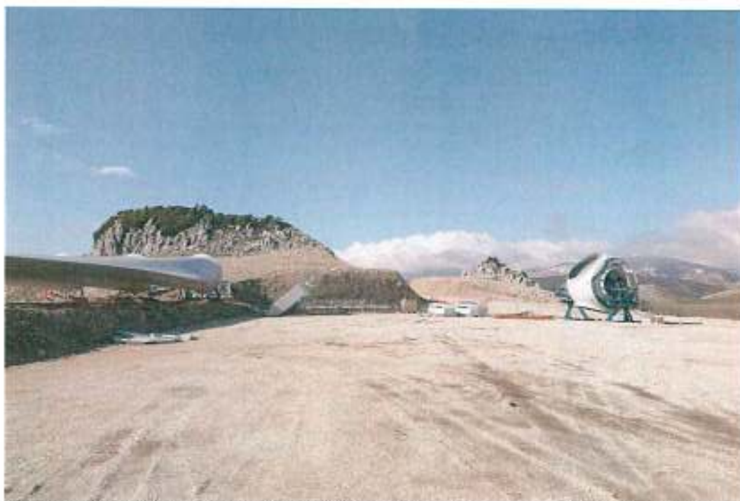
Foto 16 - Spianamento della parte sommitale per centinaia di metri quadri (compresa la Ripa circa 13.800 mq) attorno a Ripa Maleportelle ed accumulo del materiale asportato, con conseguente alterazione dei versanti e della circolazione idrica.
