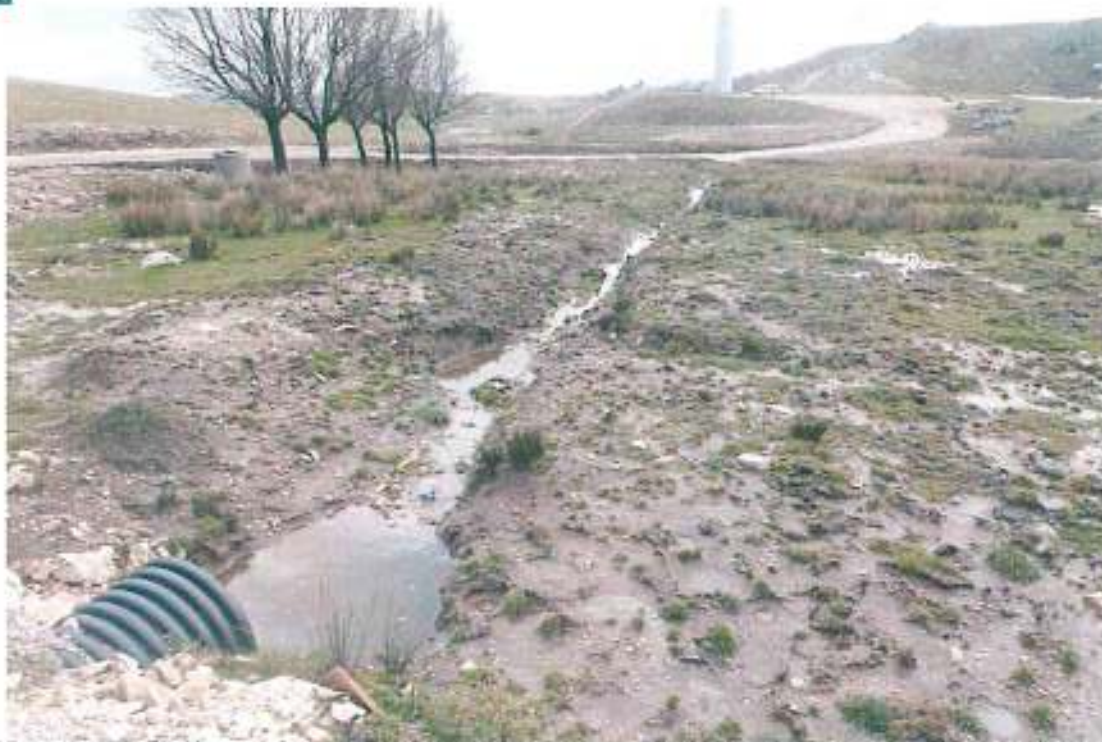
Foto 17 - Alterazione della circolazione superficiale delle acque con intubamenti e creazione di canaletti di scolo nell'area umida segnalata
