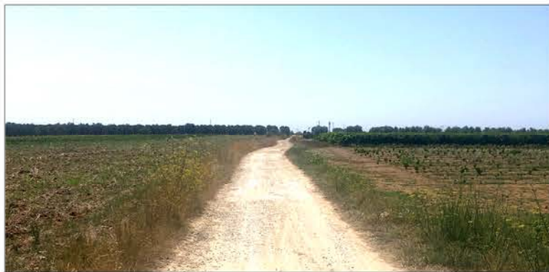
TIPO 2.1 - pavimentazione naturale in discreto stato
