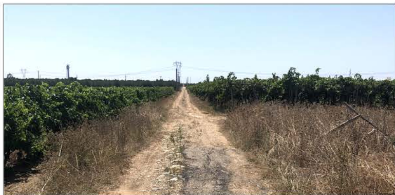
TIPO 3 - pavimentazione naturale in pessimo stato
