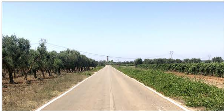
TIPO 1 - pavimentazione in conglomerato bituminoso
