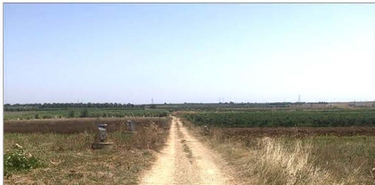
TIPO 2.2 - pav. naturale in discreto stato (allargamento)
