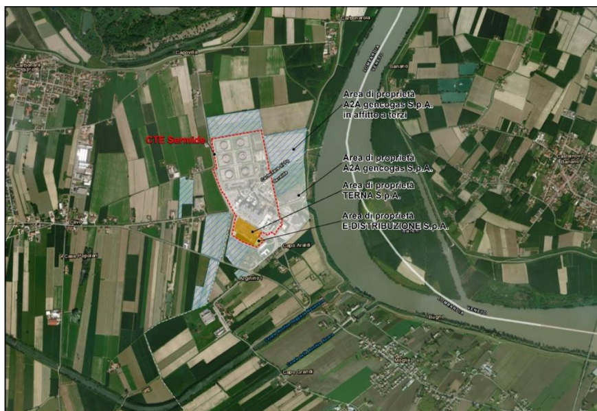
Figura 1: Localizzazione della Centrale Termoelettrica A2A gencogas di Sermide
