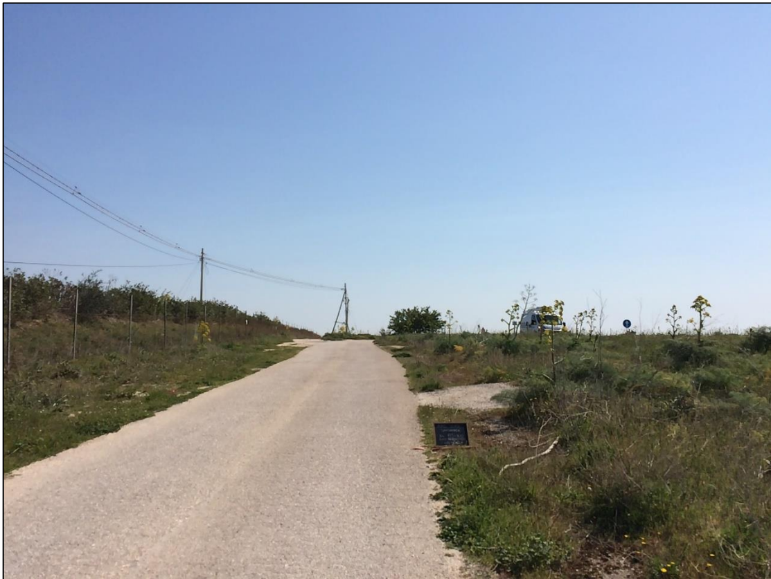
Figura 46. S.S. 89, lato nord, km 175+500
