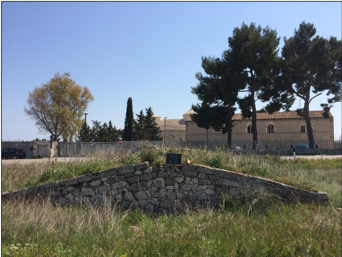
Figura 41. S.S. 89, lato nord, km 175+800. Cisterna davanti San Leonardo
