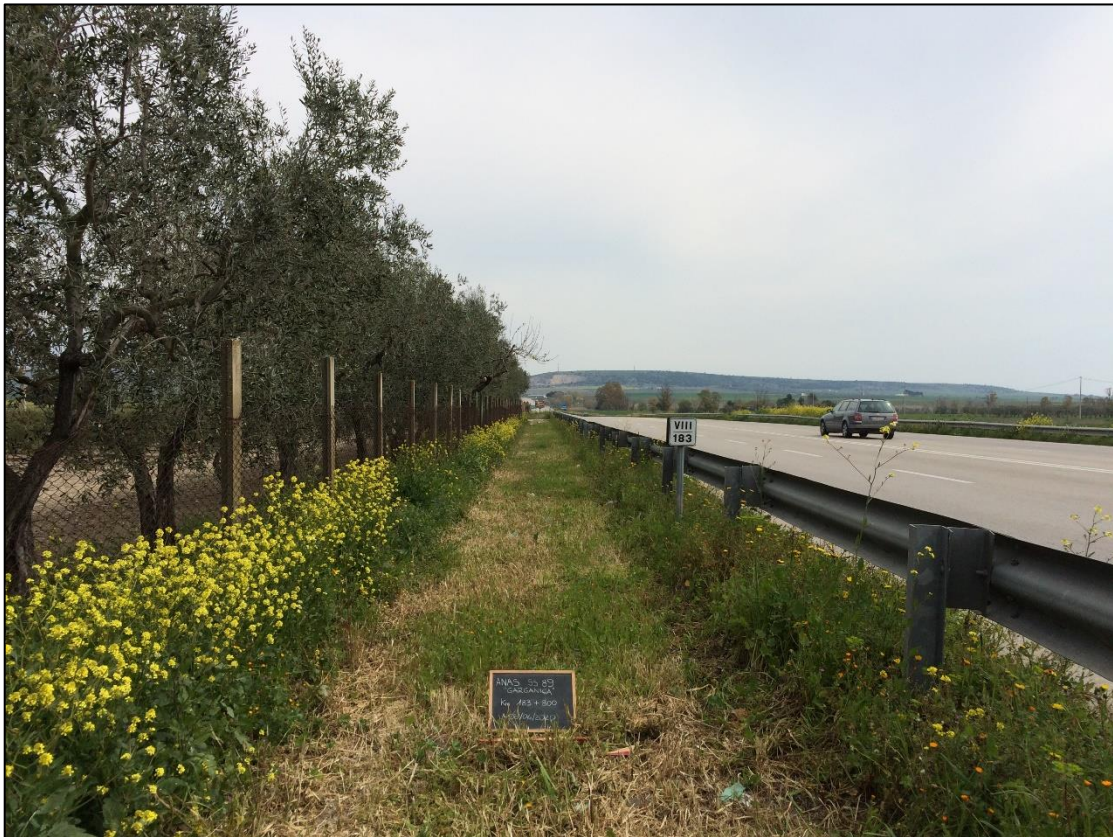
Figura 6. S.S. 89, lato nord, km 183+800
