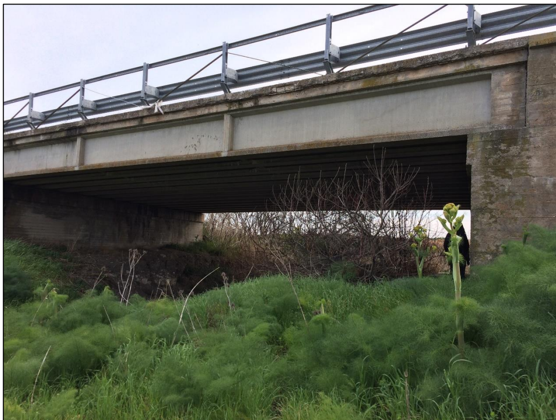
Figura 8. Ponte sul torrente Candelaro, lato nord
