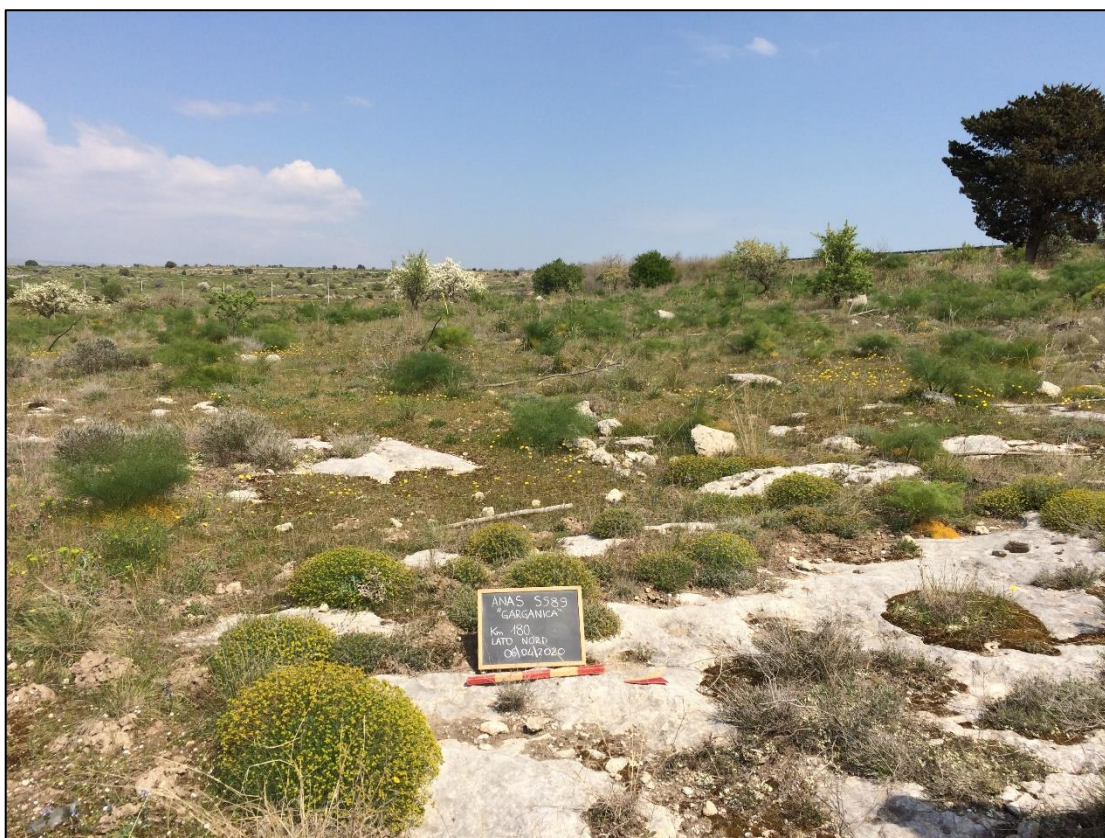
Figura 24. S.S. 89, lato nord, Km 180
