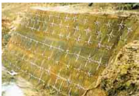
Stabilizzazione mediante soil nailing
