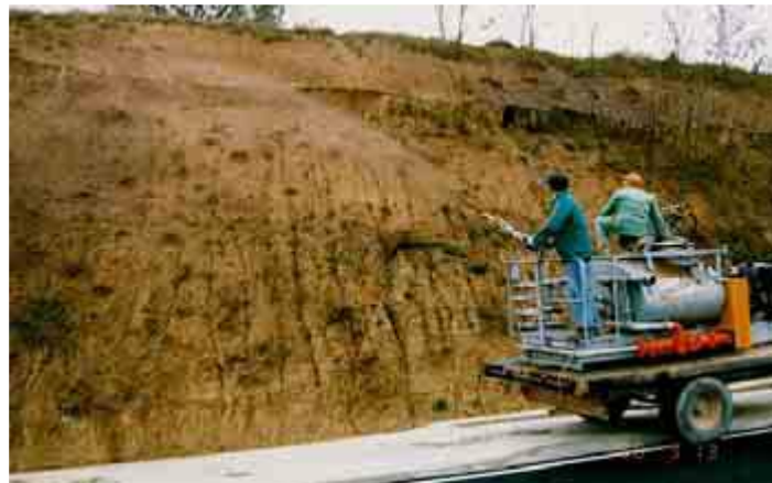
Inerbimento della scarpata mediante idrosemina
