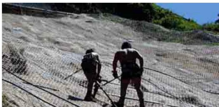
Rivestimento antierosivo mediante biostuoia e rete metallica a doppia torsione
