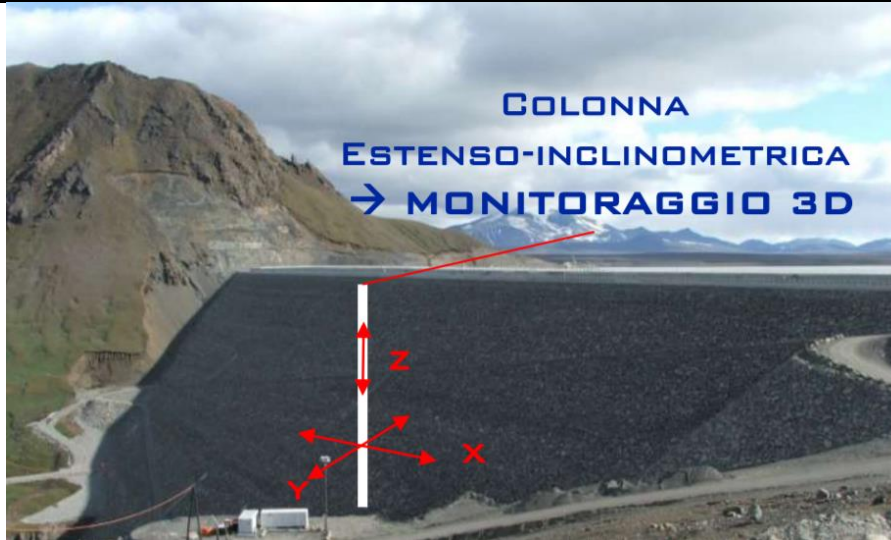
Figura 1 – Esempio di colonna estenso-clinometro per il monitoraggio 3D (nominato in planimetria NR1J01D29PZMF0000001A come TIC)
