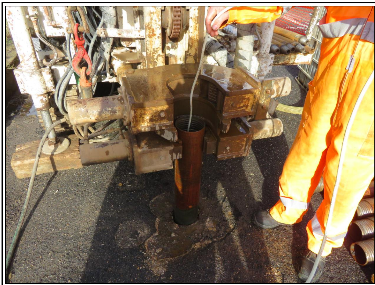
Sondaggio S_X2-Rilievo masse metalliche in foro
