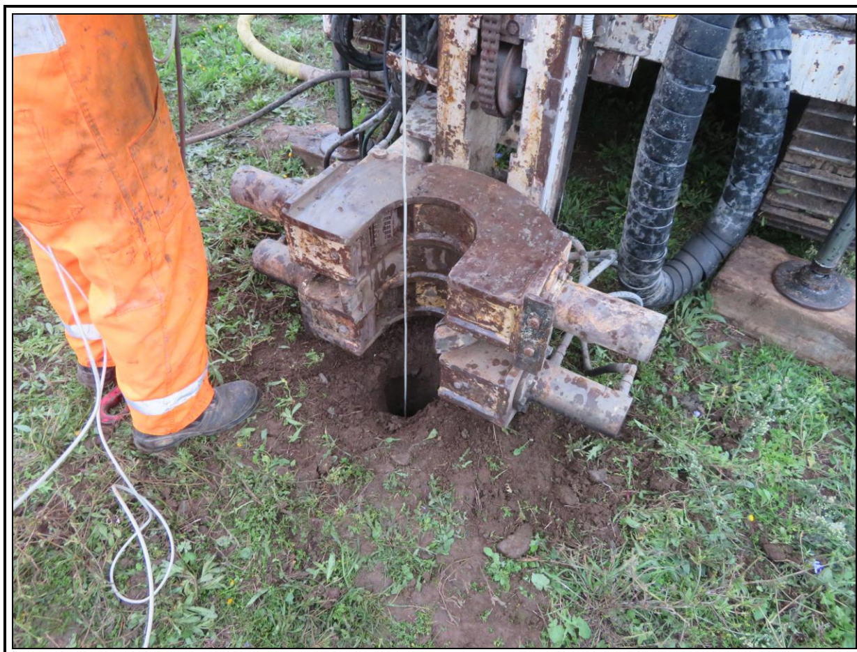
Sondaggio S_X4-Rilievo masse metalliche in foro
