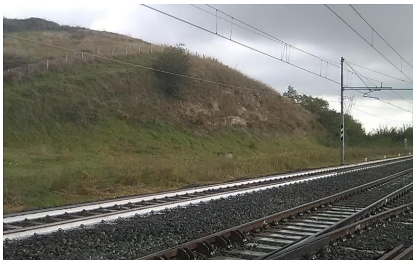
Fig. 13-6 Sopralluogo presso la stazione di Crocicchie (Ottobre 2018)
