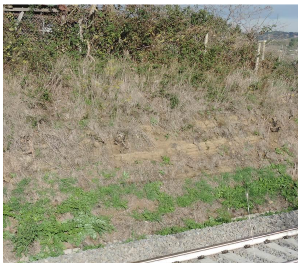
Fig. 13-1 Affioramento di Tufi Stratificati a ridosso dell’asse Ferroviario.
