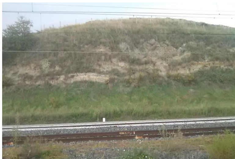
Fig. 13-5 Sopralluogo presso la stazione di Crocicchie (Ottobre 2018)
