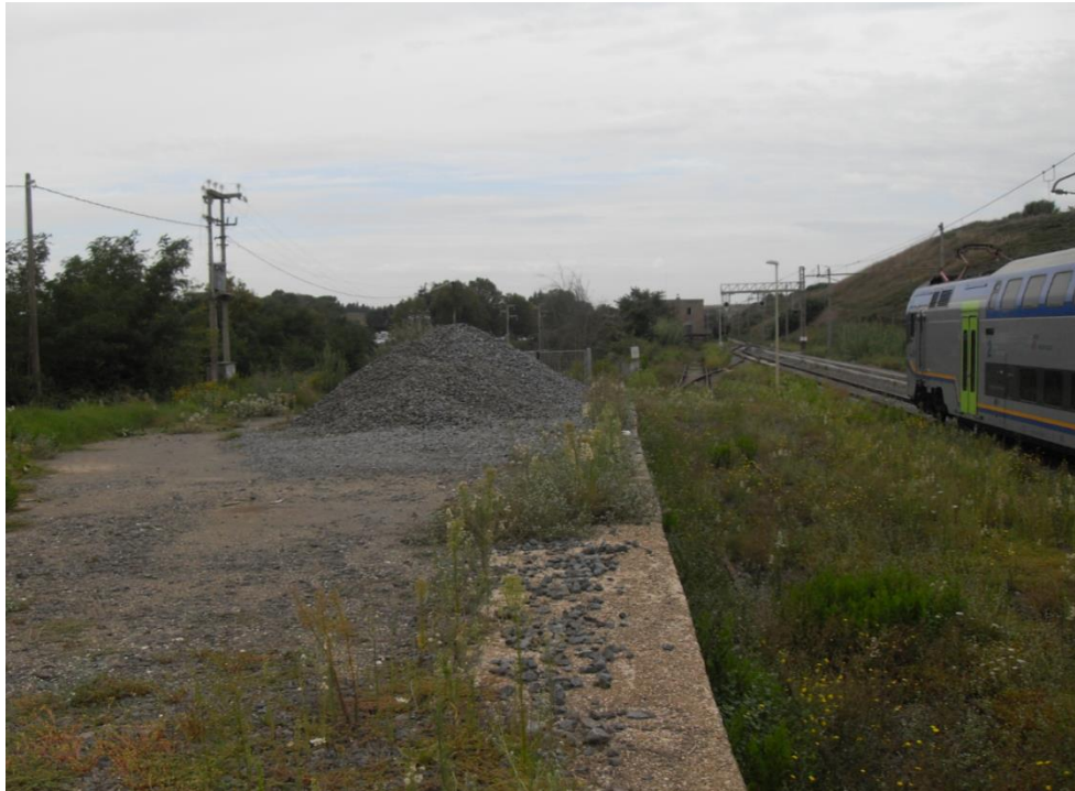
Foto 2 (vista dell'impianto attuale di Crocicchie)
