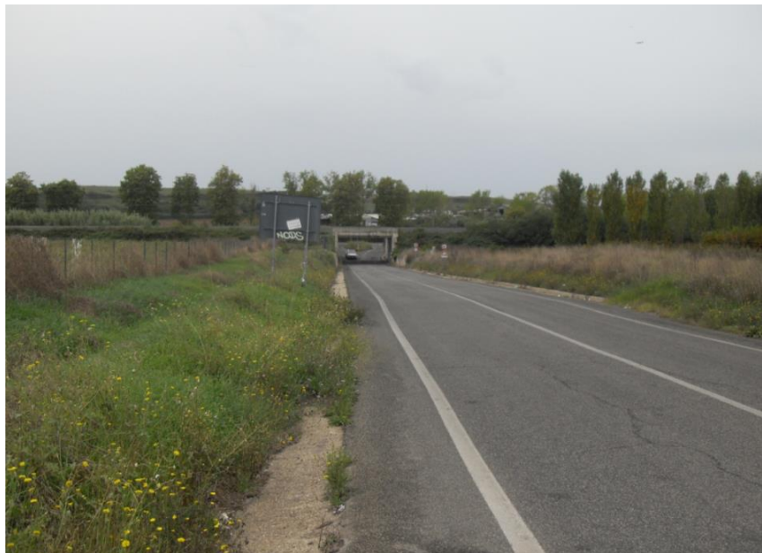
Vista della viabilità d'accesso (sottovia su via dell'Anguillara)
