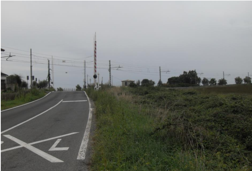
Vista della SPN4B (lato aree di cantiere)
