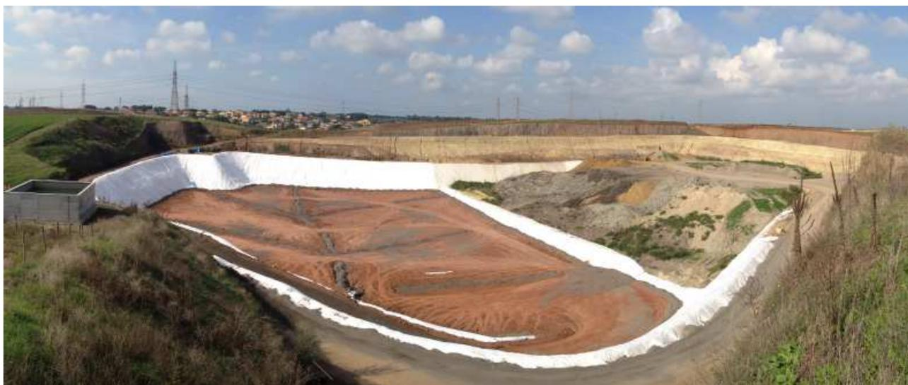
*Immagine dell'invaso adibito a discarica di inerti. In evidenza gli strati per la coibentazione del fondo e del perimetro.*
