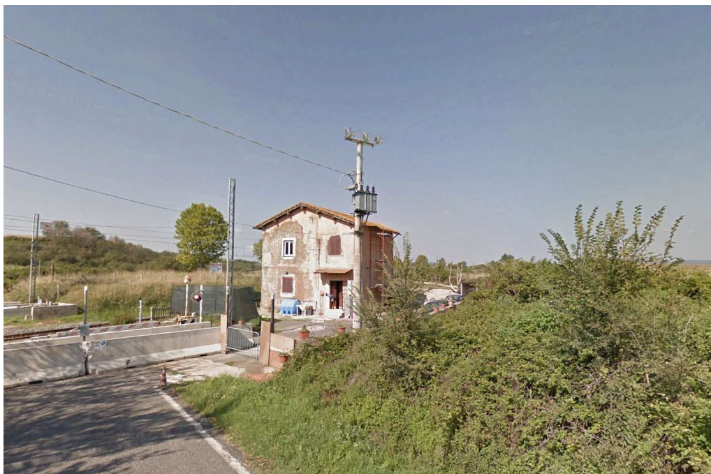
Figura 13: edificio al km 38+153; vista dal basso
