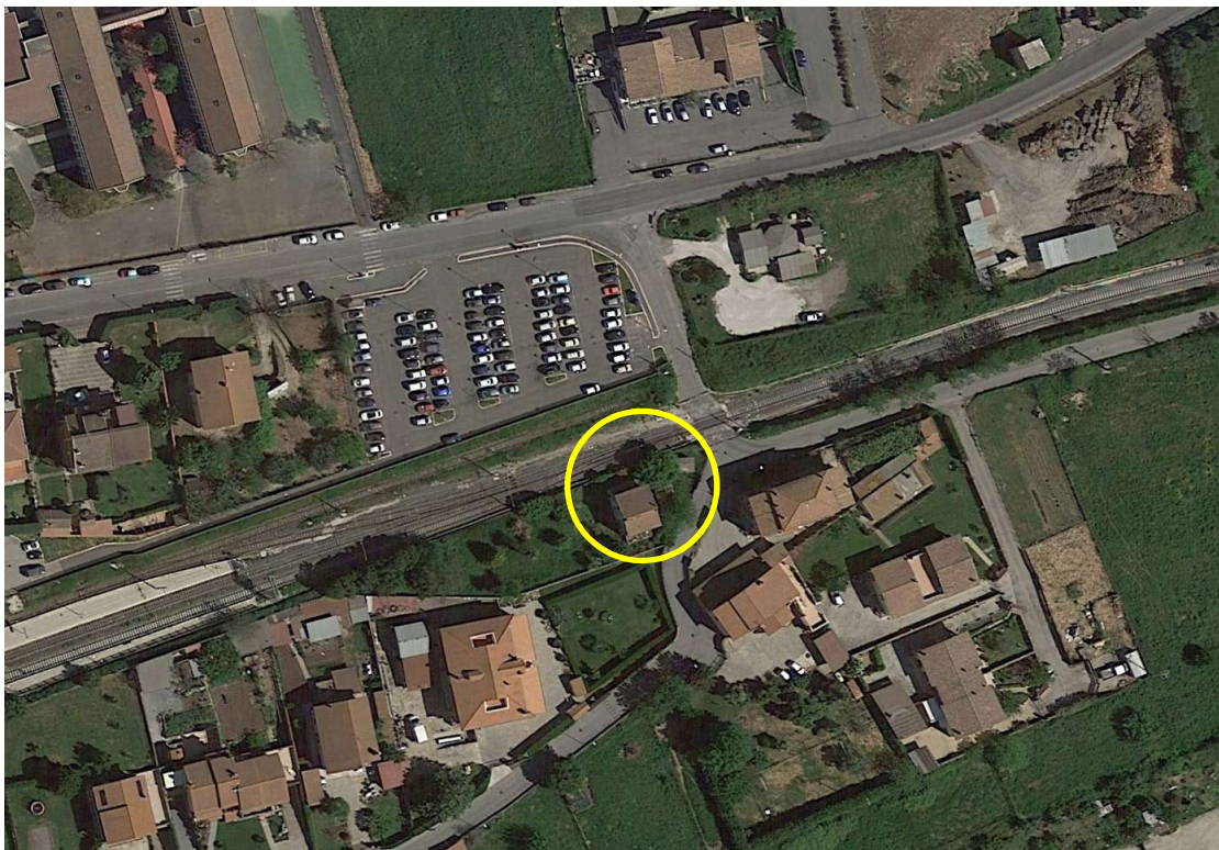
Figura 5: edificio e baracche al km 30+376
