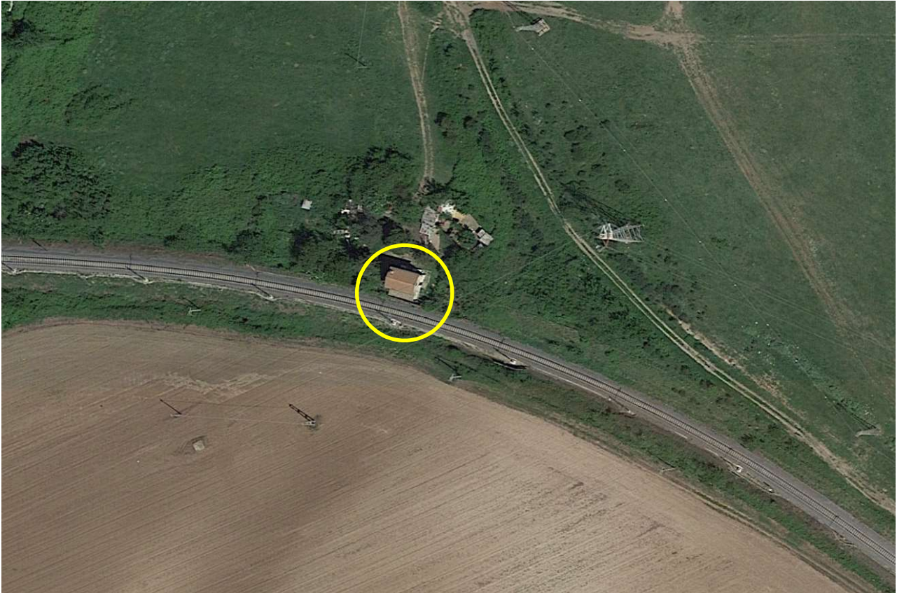
Figura 2: edificio al km 28+728
