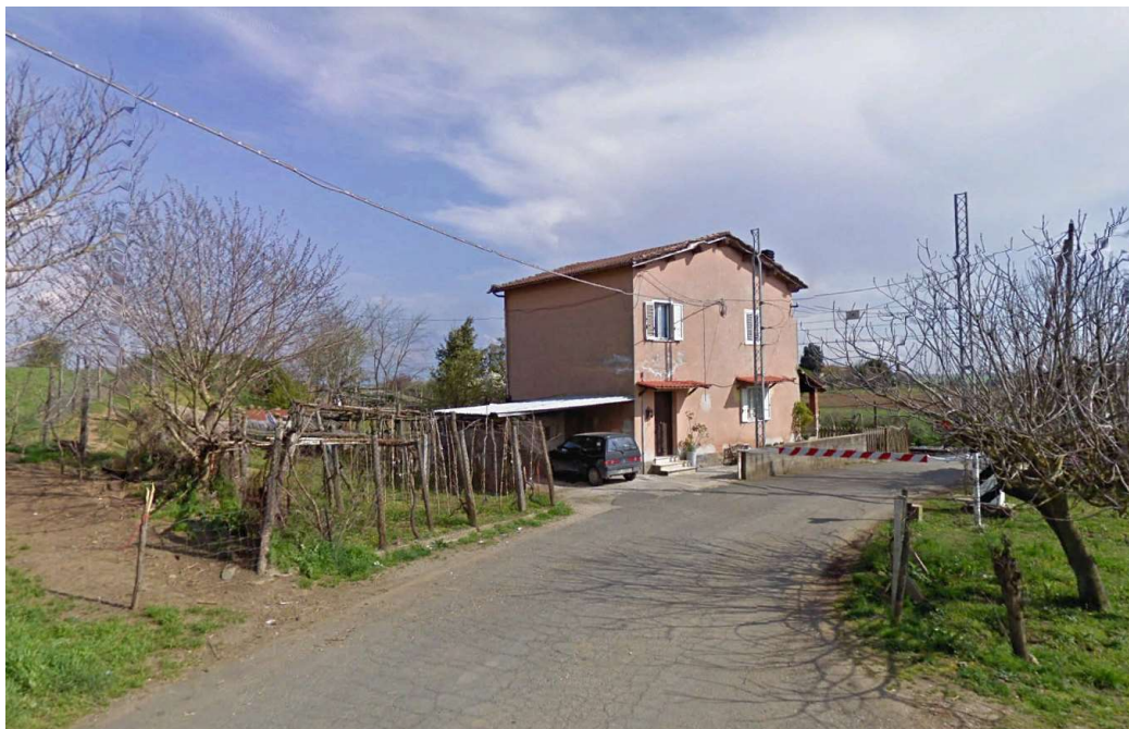
Figura 4: edificio al km 29+514; vista dal basso
