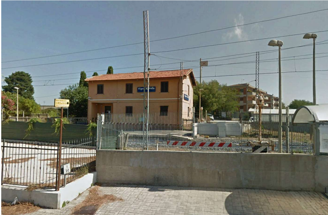
Figura 15: F.V. al km 39+235; vista dal basso
