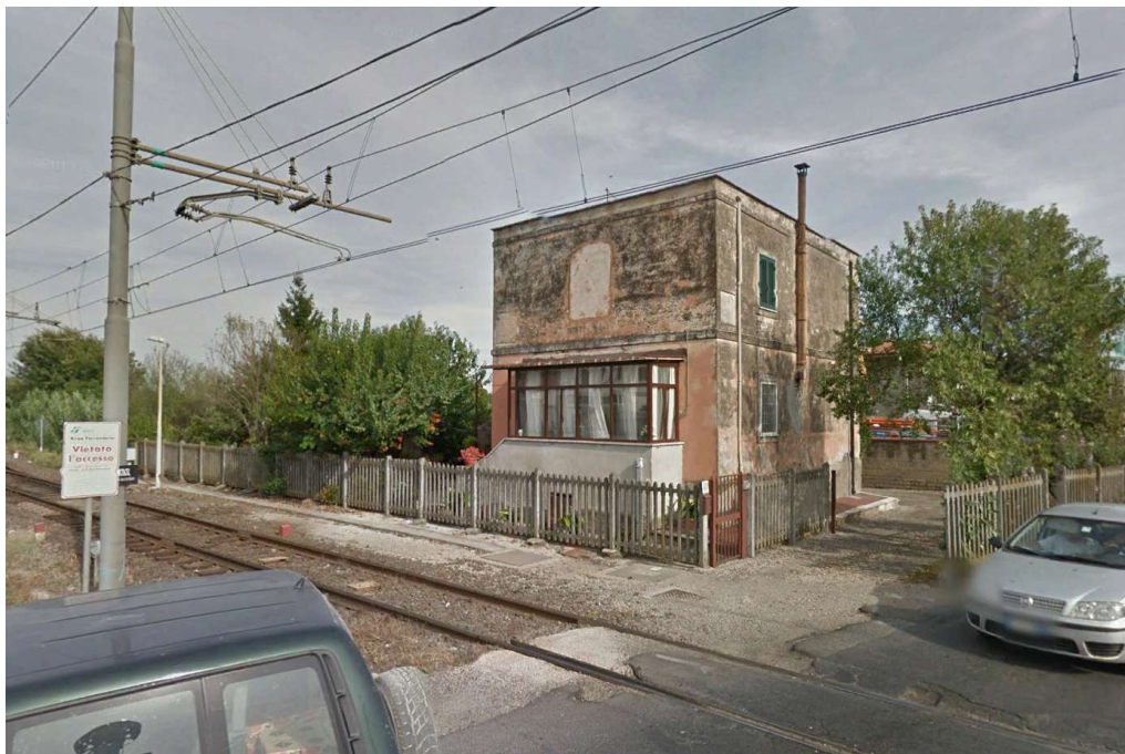
Figura 9: edificio e baracca al km 30+814; vista dal basso
