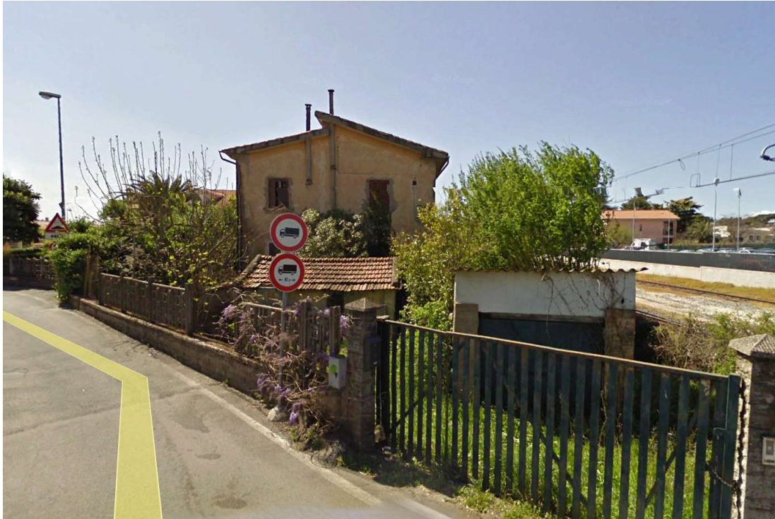
Figura 6: edificio e baracche al km 30+376; vista dal basso
