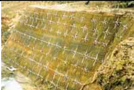
Figura 5-10: Stabilizzazione mediante Soil Nailing
