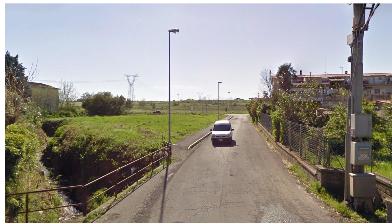
Figura 4-25 Condizioni percettive ante operam intervento NV03
