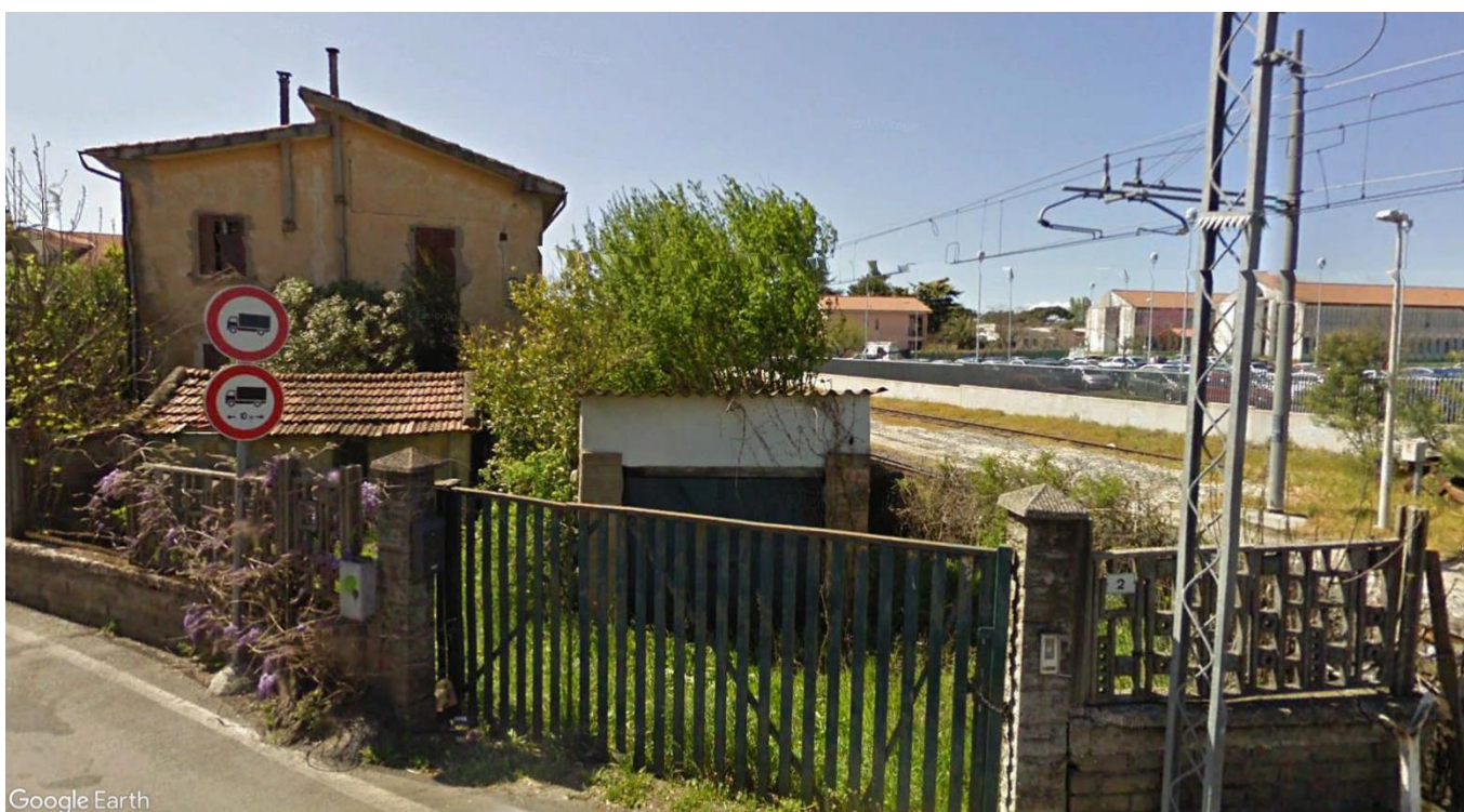
Figura 4-13 Edificio residenziale e manufatti di pertinenza interferenti dall’opera in progetto FV01 alla pk 30+814 per il quale si prevede la demolizione
