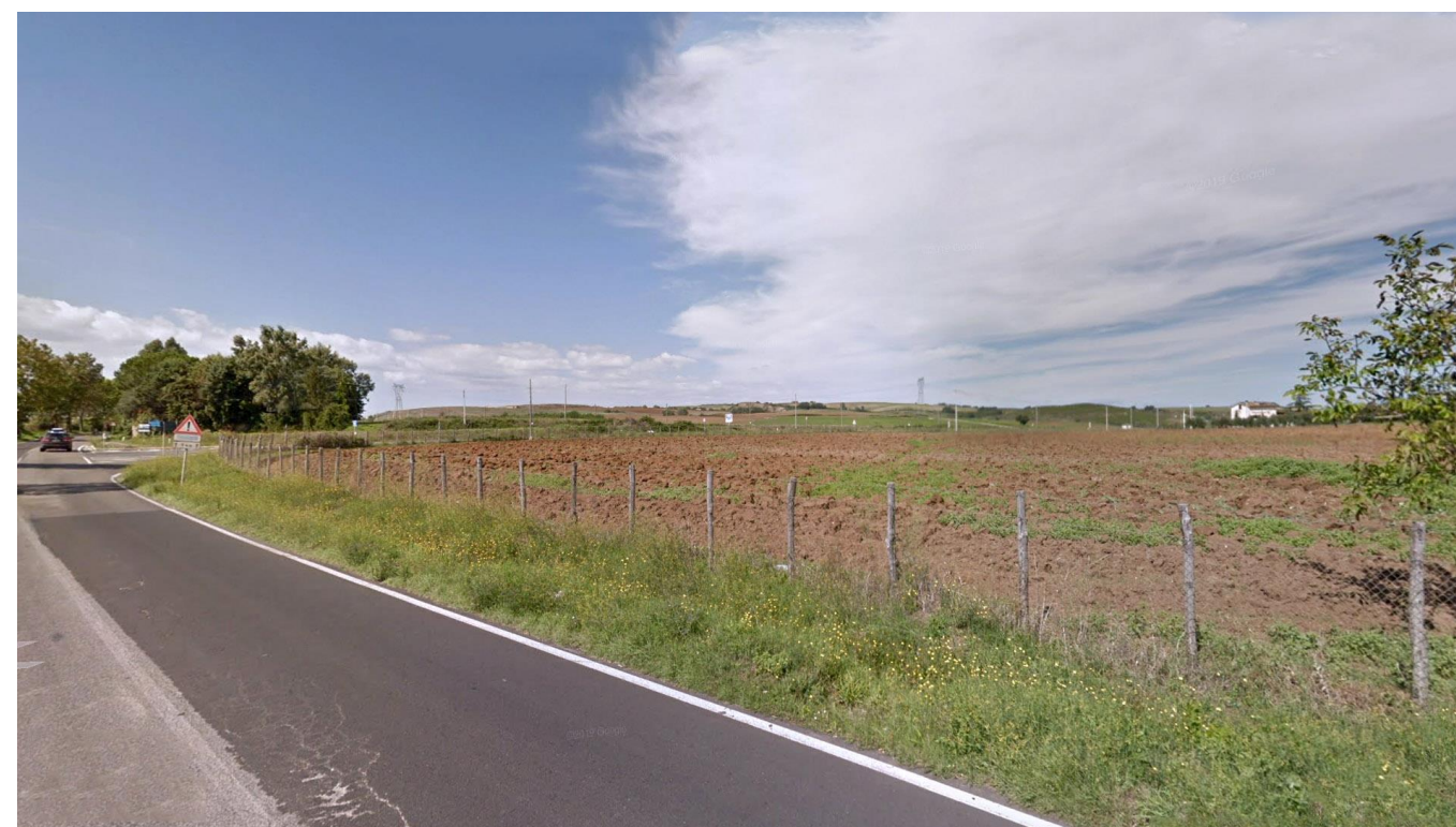
Figura 4-27 Condizioni percettive ante operam intervento NV04.
