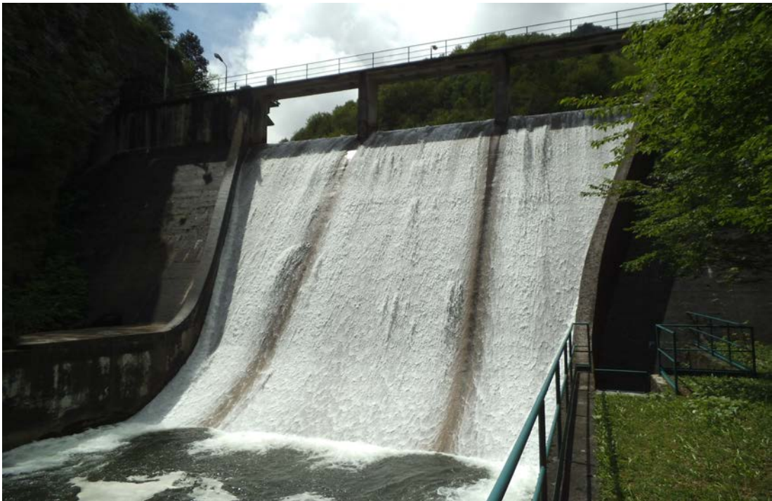
Foto 2. Vista a valle dello sfioratore
